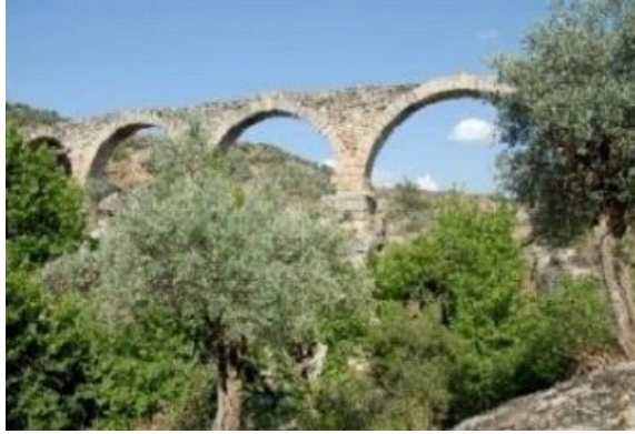
Resim 5. İnce Kemerli Köprü (Ömür Koç arşivi).
