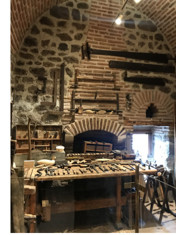
Resim 10. Moloz Duvarda Tuğla Bütünleme Uygulaması (2019)
