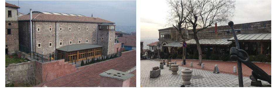
Resim 5. Arka Cephe (2007) (Solda) Resim 6. Resim 8. Ön Cephe (2019) (Sağda)
