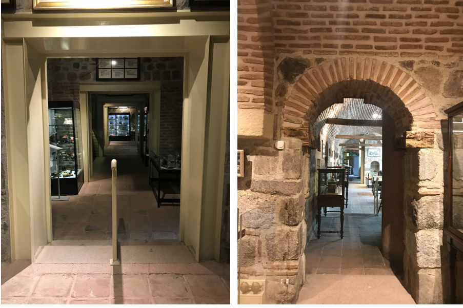
Resim 5. Ara Duvarlara Açılan Geçitler (2019) (Solda) Resim 6. Kapı Hatılları ile Kemer Aynalıkları (2019) (Sağda)
