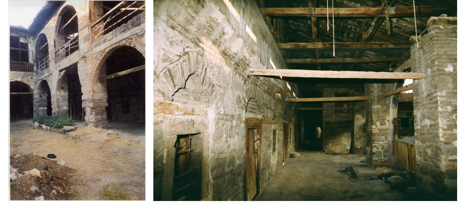
Resim 3. Kuzeydoğu Revak Ayakları (1992) Resim 4. Üst Revak Tonoz İzleri (1992)
