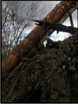
Fotoğraf 5: Kışla Köyü Su Değirmeninin Değiştirilen Cebri Borusu
