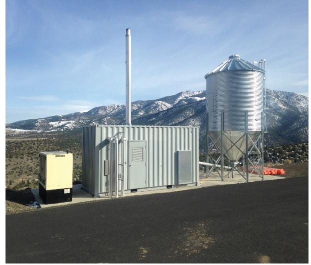
Şekil 4. Grant County Havalimanı'nda biyokütle tesisi için hammadde depolama kutusu [27].
