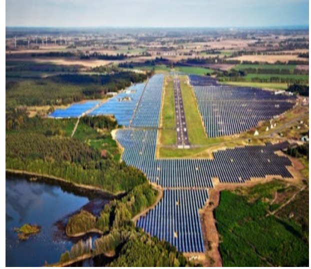
Şekil 2. Neuhardenberg havalimanı güneş güneş enerjisi santrali [34].
