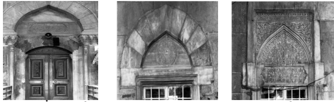
Resim8. İç Portal Resim 9-10. Son cemaat yeri sağ ve sol pencere
