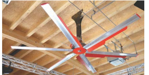
Şekil 2. Ahırlarda sıcaklığın kontrolü için kullanılacak tavan fanı (Summer ve ark., 2019). Figure 2. Ceiling fan that can be used for temperature control in stables
