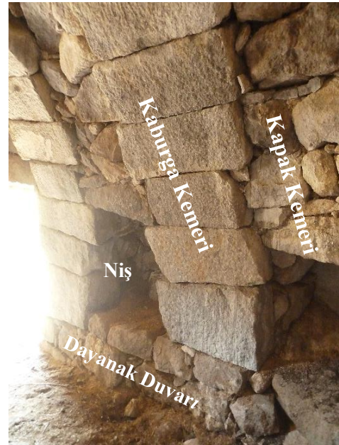
Fotoğraf 8 Atkı kemerli tonoz sistemi (Burak Falay Arşiv).
