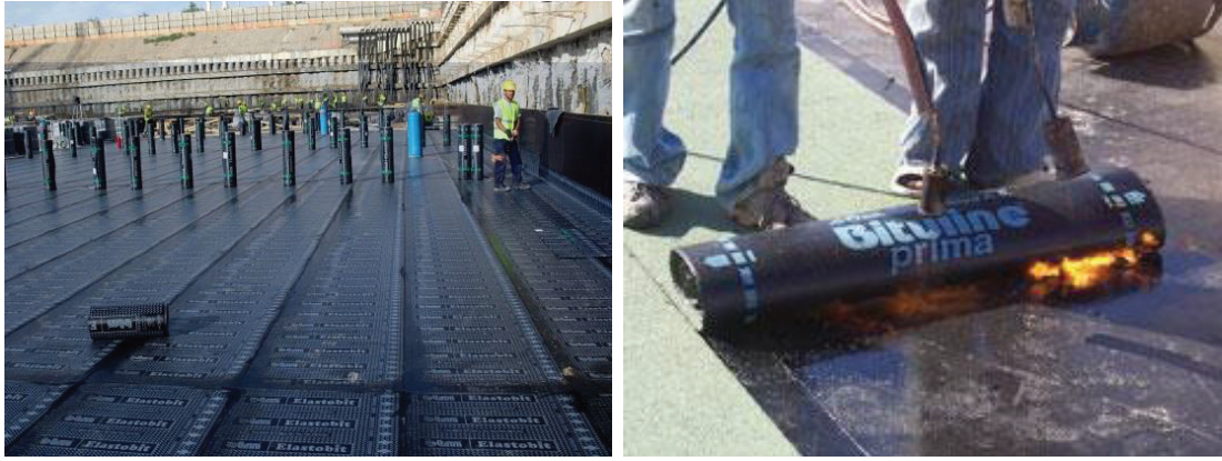
Şekil 3.2 Plimer bitümlü örtülerin uygulaması
