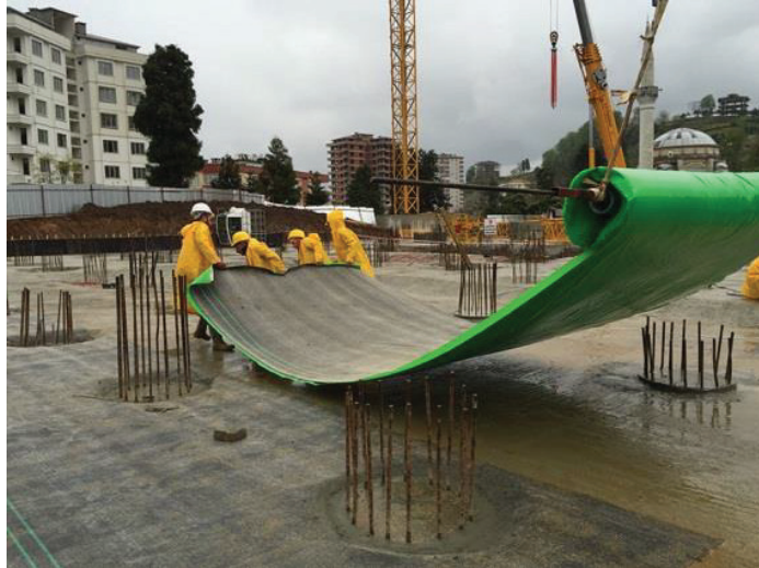
Şekil 3.4 Bentonit şilte uygulaması.
