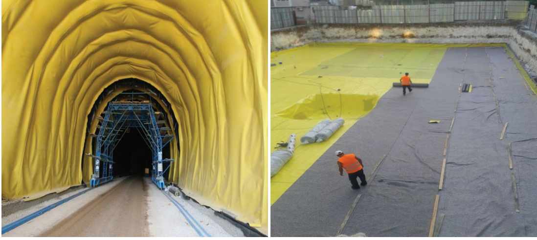
Resim 3.3 Sentetik su yalıtım örtü uygulaması.
