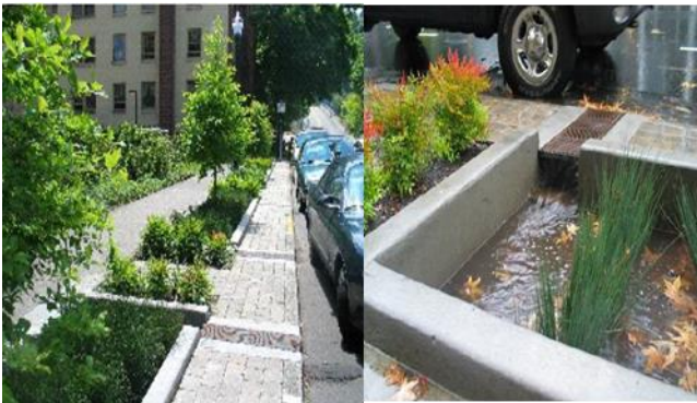
Şekil 3.3. İnfiltrasyon sağlayan/Akışkan Ekim yastığı kesiti (San Mateo Tasarım rehberinden uyarlanmıştır)
