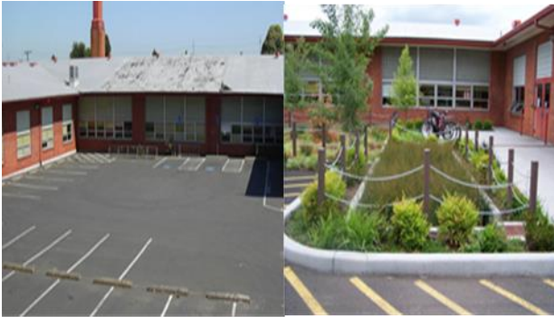
Şekil 3.6 (a) ve (b). Mount Tabor Middle School'un geçirimsiz yüzeye sahip bahçesinin ve otoparkının yağmur bahçesine dönüştürülmesi (Asla, 2019)
