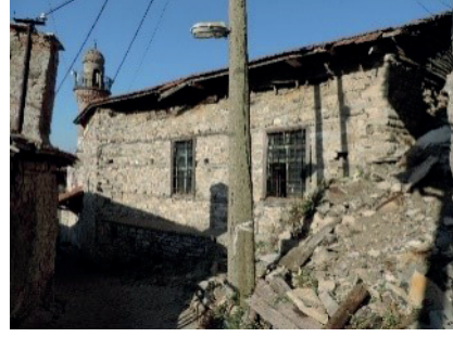
F. 28: Minareli Cami, batı cepheye bakış
