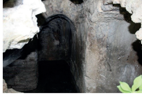
F. 39: Çamaşırhane, su deposunun içinden görünüm
