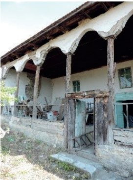
F. 25: Minareli Cami, kuzey cepheye bakış
