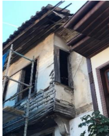
Şekil 14. Geleneksel Kaleiçi evlerinde yapı malzemesi ve yapı strüktürü [26].
