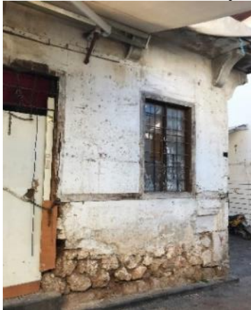
Şekil 14. Geleneksel Kaleiçi evlerinde yapı malzemesi ve yapı strüktürü [26].
