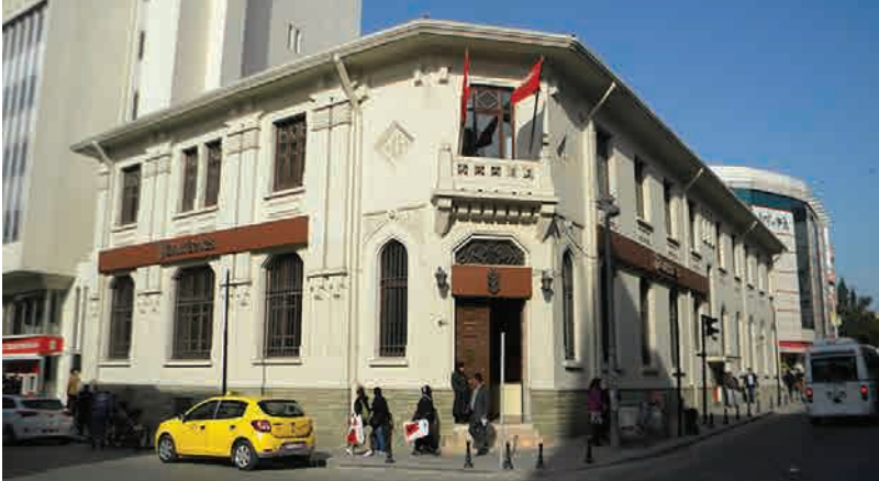
G. 7. Adana Şube Binası (Fotoğraf tarihi bilinmiyor) (Duygu Saban, "Giulio Mongeri'nin Banka Tasarım İlkeleri-Ziraat Bankası Adana Şubesi Örneği", 121).
