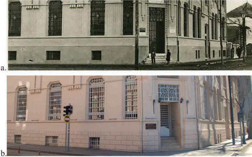
G. 16a. 1930'lu Yıllarda Yapının Kaldırım ile İlişkisi (ETBA) 16b. Günümüzde Yapının Kaldırım ile İlişkisi (Rabia Temel, 2018).
