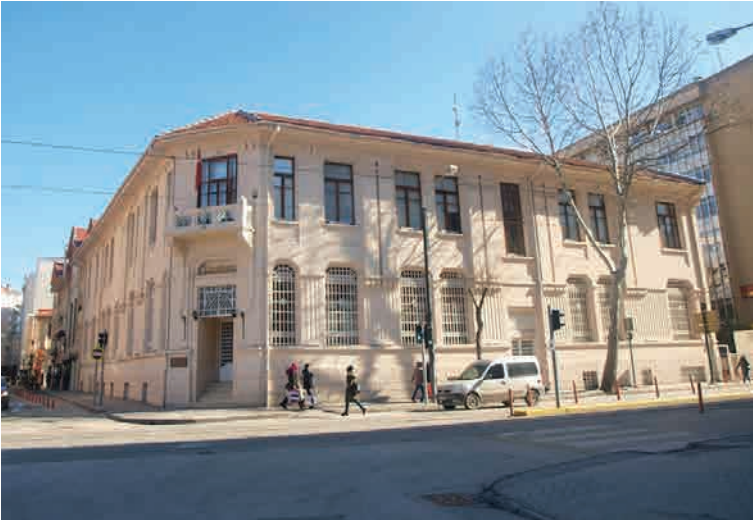
G. 4. Eskişehir Ziraat Bankası Kuzeybatı ve Güneybatı Cephesi (Rabia Temel, 2018).
