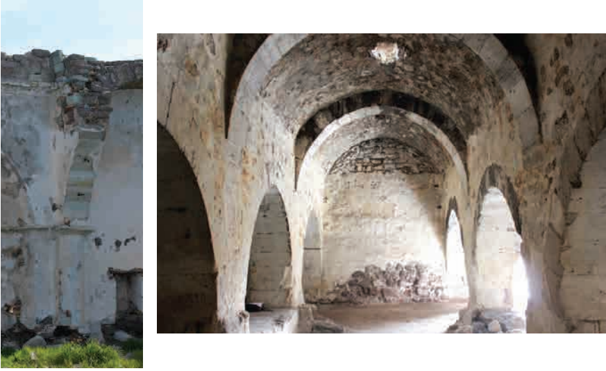
G. 9. Birinci Durum Sınıfındaki Bölgeler, solda kilisenin bir sütuncesi (Emre İpekci, 2015), sağda hanın barınak kısmındaki tonoz, kemer ve duvarlar (FeYZa Durmuşlar, 2017)
