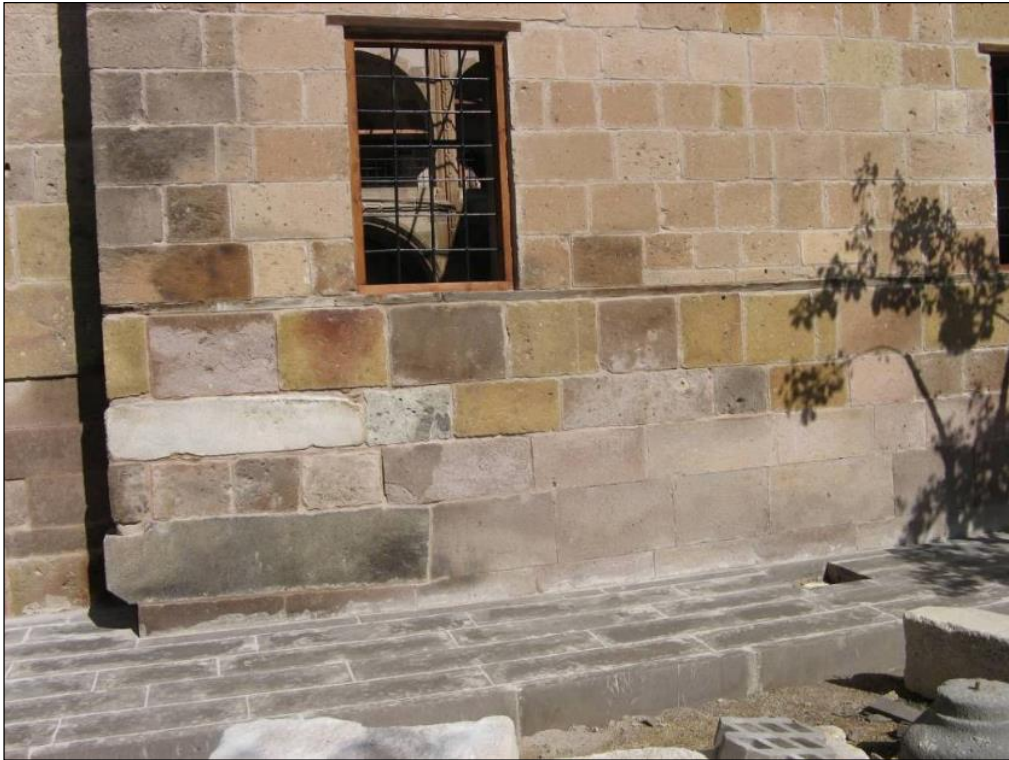
Şekil 14. Farklı litolojik özelliklerdeki taşların birlikte kullanımı ve farklı yüksekliklerdeki nemlenme sonucu bozunmalar
