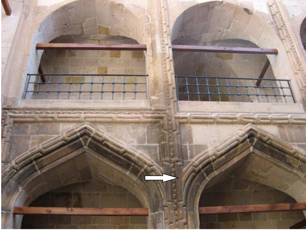
Şekil 18. Yapının iç kesimlerinde iğnimbiritlerde kirlenme etkilerinin fazlaca görüldüğü alanlar
