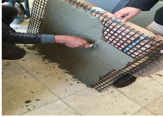
Şekil 4. Tuğla duvara sıva uygulanması
