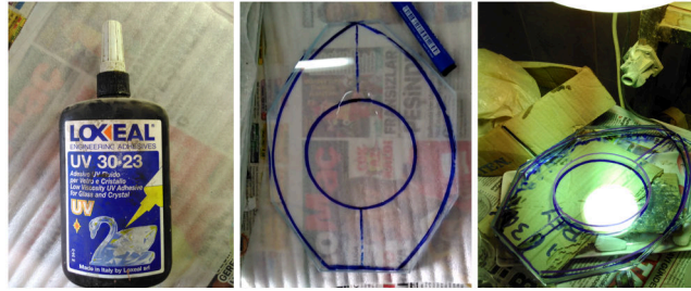
Resim 2. Camların UV yapıştırıcı ile yapıştırılması
