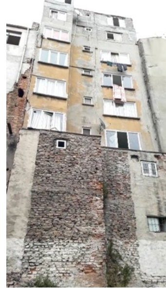
Şekil 18: Kâgir üstü ek katlarla 10 katı aşan yapı Kaynak: Can Bulubay Arşivi
