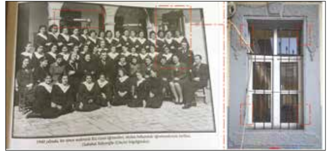
Fotoğraf 27. 1940 tarihli fotoğrafta görünen pencerede yer alan panjurun menteşe izleri (Rifaioğlu, M. N., 2019. Kaynak: Nakib, 2012). Hinge traces of the shutter in the window which is seen in the photograph dated 1940.
