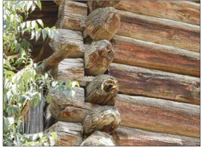
Fotoğraf 45. Yığma kütük duvar (kara boğaz) Kurusaray Köyü / The log walls with kara boğaz technique, Kurusaray Village, 2018.
