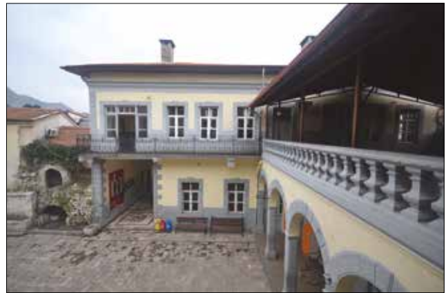
Fotoğraf 6. Ana avlunun Kuzeydoğu cephesi ve ikinci avluya geçiş mekânı (Rifaioğlu, M. N., 2019). / North-east facade of the main courtyard and transition space between main and second courtyard.
