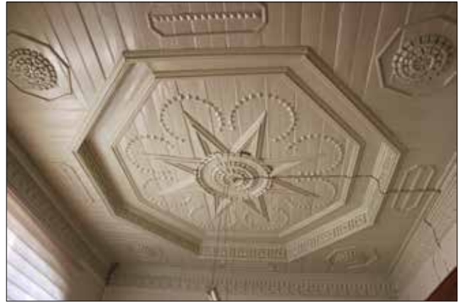
Fotoğraf 12b. Zemin katta bulunan özgün tavanlardan bezeme detayları. / An ornament detail of a ceiling in ground floor.
