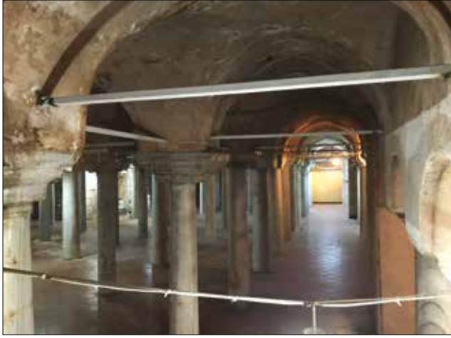
Fotoğraf 7: Myrelaion Rotondası'nın İç Görünümü / Myrelaion Rotonda's Interior (Mustafa Armağan, 2019)
