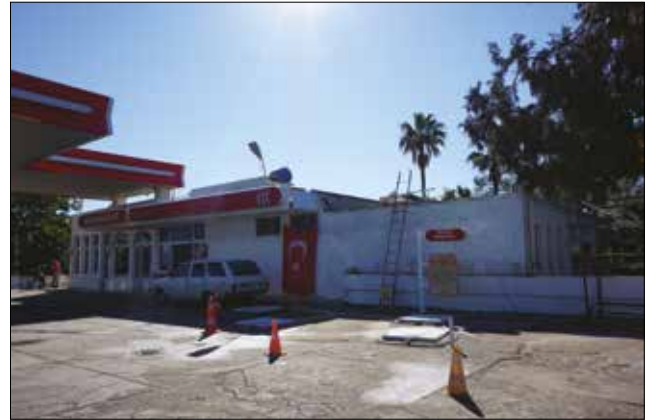
Fotoğraf 21. Ön cephe (Uçar, 2020) / Front side view
