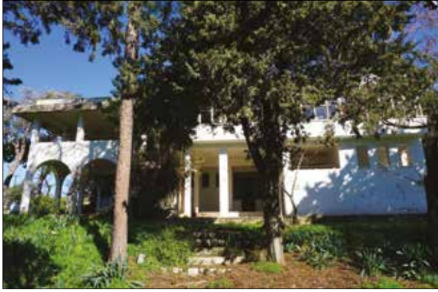
Fotoğraf 16. Genişletilen lokantanın cephe görünümü (Uçar, 2020) / Front view of the expanded restaurant
