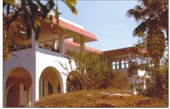
Fotoğraf 13. Yapıya eklenen teras (Can GİRĞİN arşivi) / Terrace added to the building
