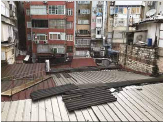
Fotoğraf 8: Myrelaion Rotondası'nın Güneyinde Yer Alan Muhdes Yapı Unsurları / Parasitic Constructions at the South of Myrelaion Rotonda (Mustafa Armağan, 2019)
