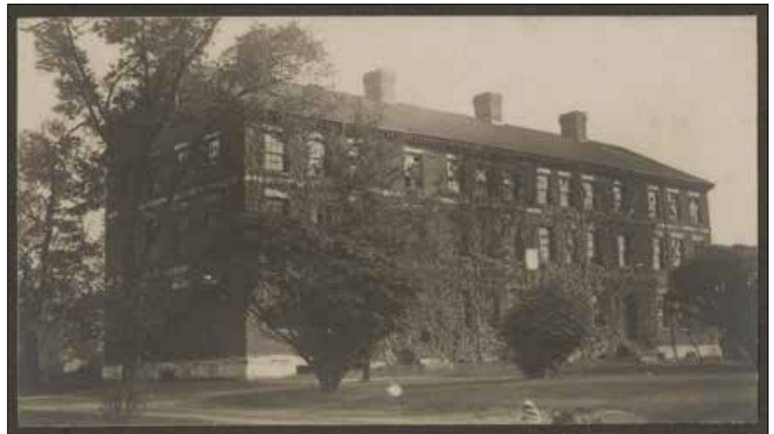
Figure 2. Old College, circa 1806. This view shows the building circa 1908 as abandoned and threatened with demolition. University alumni rallied to save the university’s oldest building in Athens’ first preservation effort. It was again renovated to celebrate its bicentennial in 2006. (Courtesy of Hargrett Rare Book and Manuscript Library / University of Georgia Libraries). / Eski kolej, 1806. Görsel binanın yıkılma tehdidi sebebiyle boşalmış olduğu 1908 yılındandır. Üniversite mezunlarının, üniversitenin en eski binasını korumak için yaptıkları yürüyüş Atina’da ilk kültür varlığını koruma çabası olarak ele alınmaktadır. 2006 yılında yapının iki yüzüncü yılı kutlamaları çerçevesinde renovasyonu gerçekleştirilmiştir.
