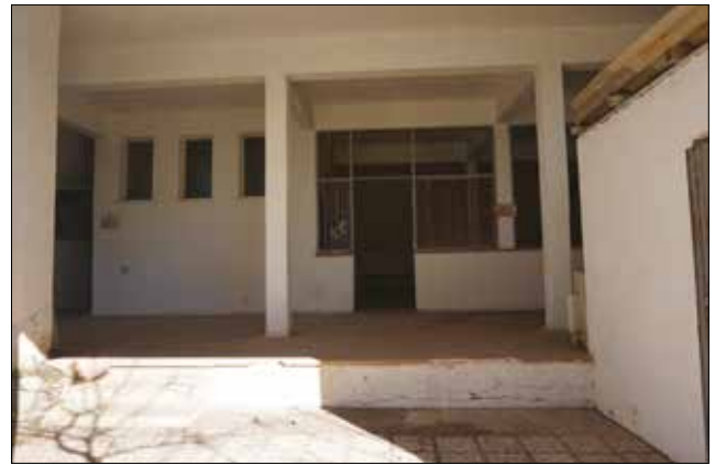
Fotoğraf 19. Umumi mutfak girişine eklenen doğrama (Uçar, 2020) / Joinery added to the kitchen entrance
