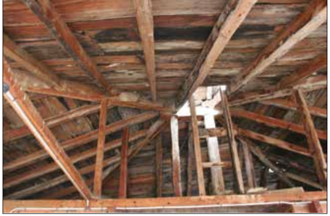
Fotoğraf 56. Çatı kurulumu, Yeni Mehmetli Köyü / The detail of the hipped roof Yeni Mehmetli Village, 2015.
