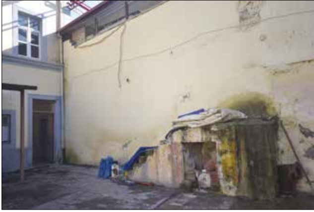
Foto 30. Müstemilat merdiveninin günümüze ulaşan kısmı (Rifaioğlu, M. N., 2019). / Remaining part of the staircase of the annex building.
