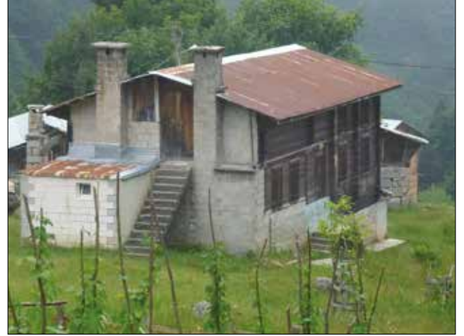
Fotoğraf 4. Kurt boğazı çantı ev, Rize, Ayder Yaylası / Çantı house with Kurt boğazı technique, Ayder Plateau in Rize, 2012.
