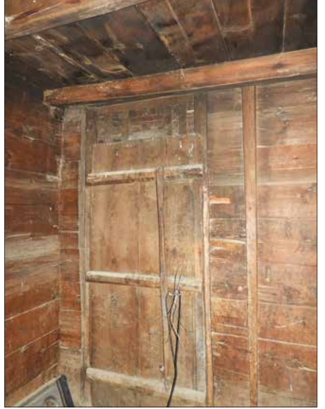
Fotoğraf 51. Kapı yanında sıkırtma, Arioğlu Köyü / The "sıkırtma" next to the door, Arioğlu Village, 2018.
