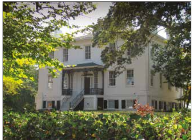
Figure 11. Camak House, 1834. Built by James Camak, one of Georgia’s most important early industrialists. Purchased by the Masonic Lodge in 1949, it subsequently served as offices for the Athens Coca-Cola Bottling Company. In the early 1990s the Georgia Trust for Historic Preservation acquired the building and sold it to the law firm of Winburn, Lewis and Barrow, subject to a conservation easement. GAgayle, 27 September 2012, CC BY-SA 3.0. / Camak Evi, 1834. Georgia’nın en önemli ilk sanayicilerinden James Camak tarafından yaptırılmıştır. 1949 yılında Mason Locası tarafından satın alınan bina Coca-Cola Şişeleme Şirketi’nin ofisi olarak kullanılmıştır. 1990’lı yılların başlarında, Georgia Tarihi Koruma Vakfı tarafından satın alınan bina hukuki koruma anlaşmasına tabi tutularak Winburn, Lewis ve Barrow hukuk bürosuna satılmıştır.
