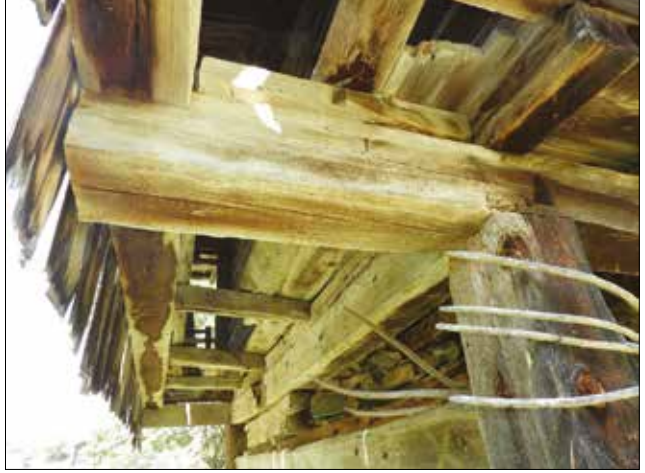
Fotoğraf 55. Tuvalet ve kilerin oturduğu çıkma detayı, Arıoğlu Köyü / Detail of the projection of the toilet and larder, Arıoğlu Village, 2018.
