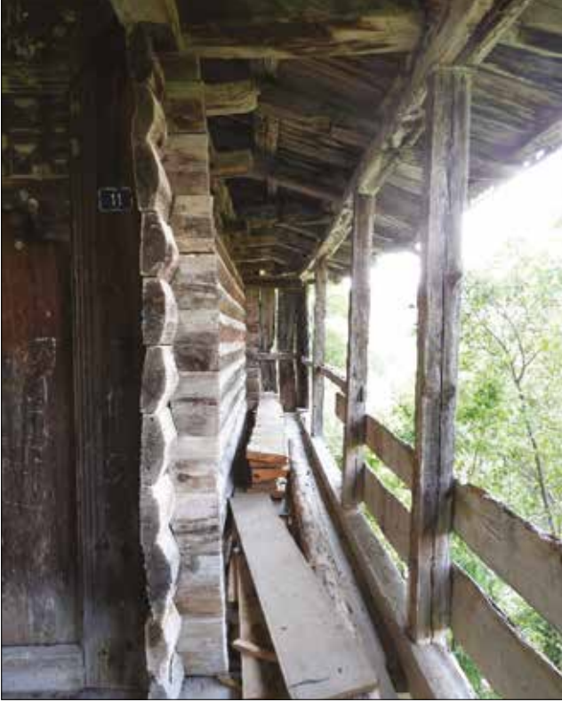
Fotoğraf 49. Kandil duvar, Arioğlu Köyü / The "kandil" wall, Arioğlu Village, 2018.
