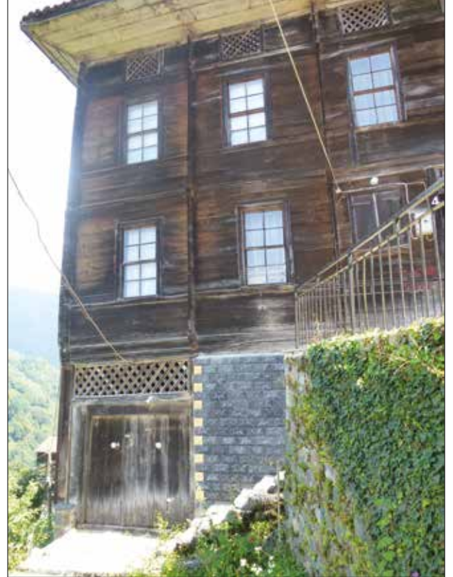
Fotoğraf 5. Kurt boğazı çantı ev, Rize, Ortan Köyü / Çantı house with Kurt boğazı technique, Ortan Village in Rize.
