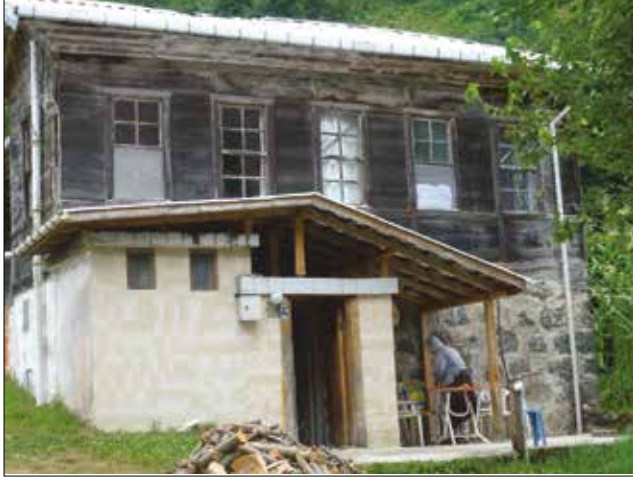
Fotoğraf 6. Çalma boğaz çantı ev, Çamlıhemşin / Çantı House with çalma boğaz technique, Çamlıhemşin, 2012.
