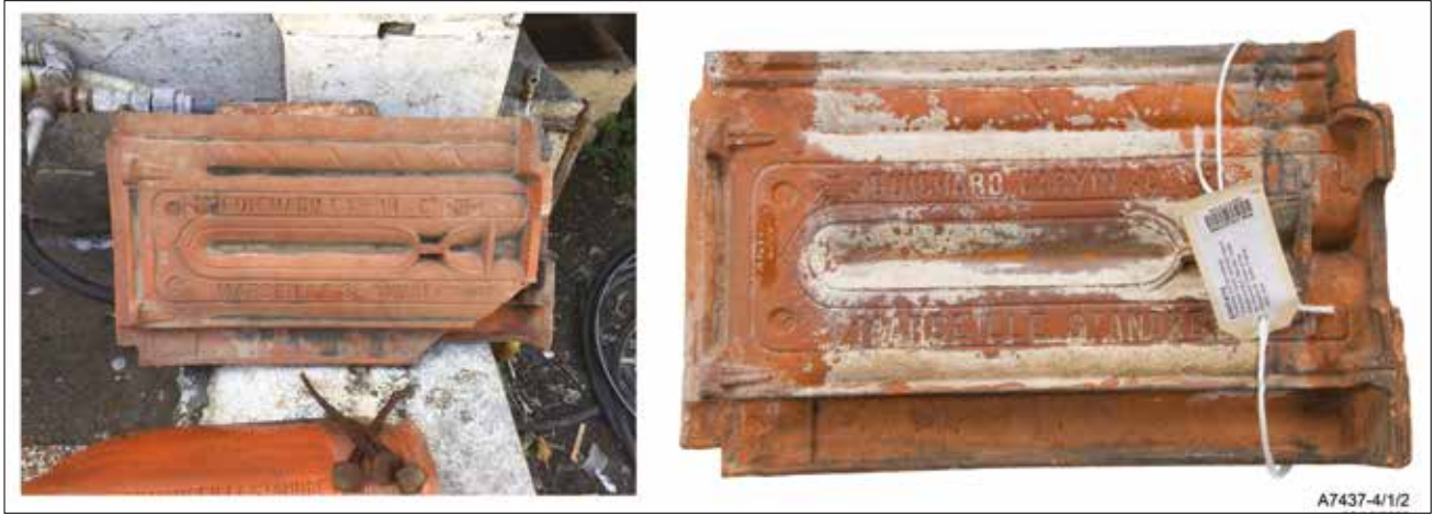
Fotoğraf 25. Yapıda kullanılan özgün kiremit ve MAAS Museum'da yer alan örneği ( Rifaioğlu, M. N., 2019; Kaynak: https://collection.maas.museum/object/190677 ). / The original roof tile used in the building and its example in the MAAS Museum.
