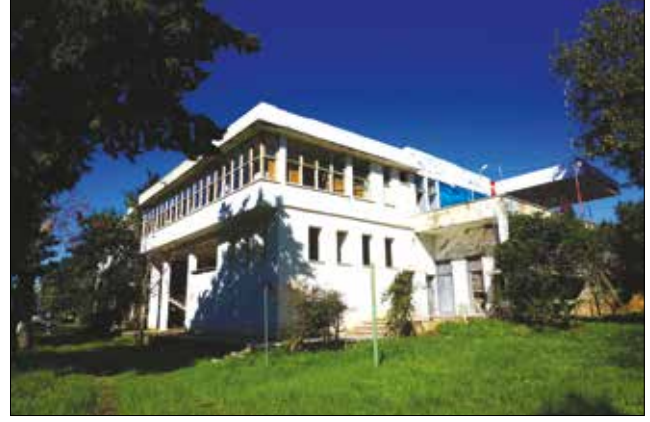
Fotoğraf 17. Değişen personel yatak odası cephe görünümü (Uçar, 2020) / Changing staff bedroom facade view
