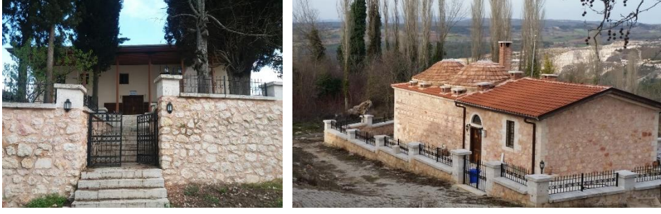
Şekil 12. İlyasbey Köyü Köy Camisi ve Hamamı 12 .
