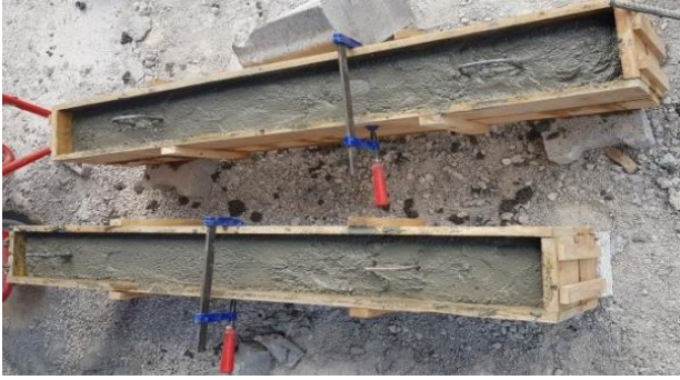
Şekil 6. Betonun kalıplara dökülmesi
