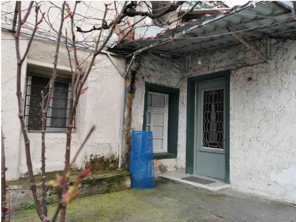
Resim 12. Karaferye Kemal Bey Camisi'nin güney-batı köşesine yapılan eklenti (Foto: Neval Konuk, 2020)
