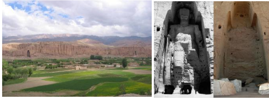
Şekil 5 Bamiyan Vadisi 46 ; Taliban tarafından yok edilen Buda heykeli (1963) ve yıkım sonrası durum 47 (2008).
