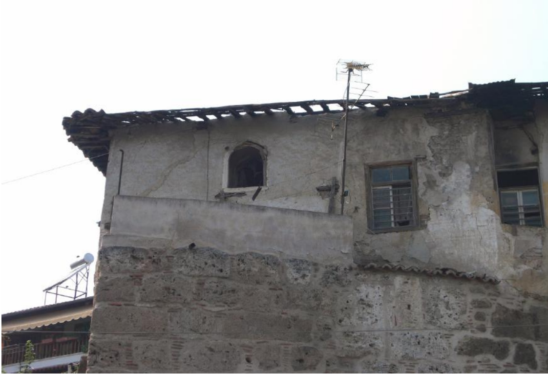
Resim 23. Karaferye Mahmud Çelebi Camisi'nin güney (kible) cephesi ve kemerli pencere detayı görünüşü (Foto: Neval Konuk, 2018)
