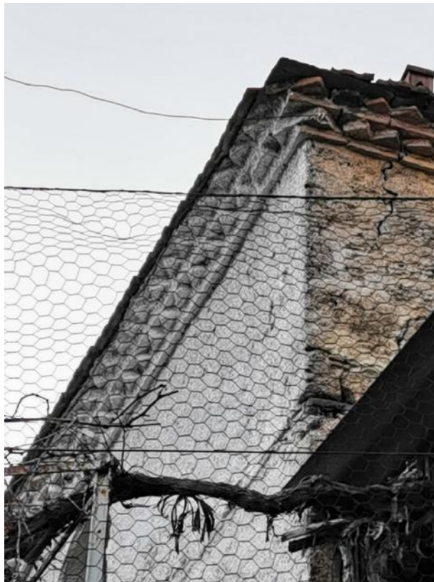
Resim 16. Karaferye Kemal Bey Camisi'nin kirpi saçak detayı (Foto: Neval Konuk, 2020)
