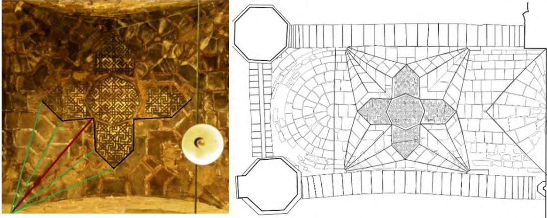
Şekil 4: Temelde bir haç tonoz planı uygulanan Divriği Ulu Cami 5 kenarlı tonozu (Sevda Atak) ve planı (Ankara Vakıflar Genel Müdürlüğü Arşivi,1999).
