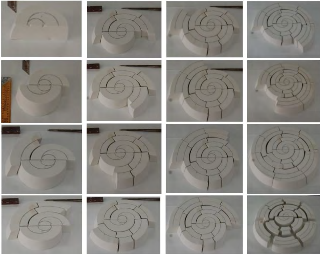
Şekil 9: On beş kesme taştan oluşan spiral merkezin gerçek eklem yataklarına göre yeniden inşası (Sevda Atak, 2017).
