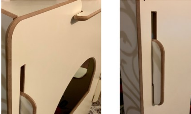
Resim 2. Ahşap oyun evinde kullanılan malzemenin birleşim noktaları Photo 2. Joining points of the material used in the wooden playhouse
