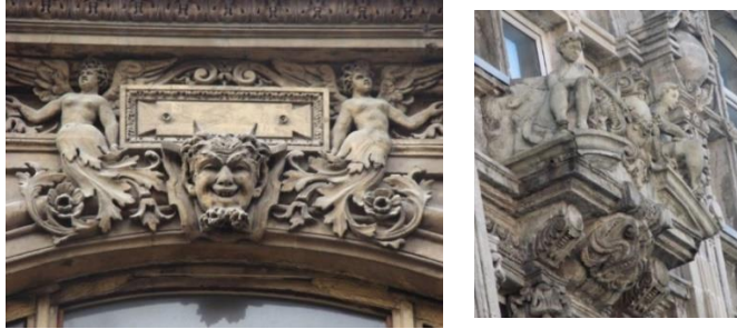
Fotoğraf 36. Frej Apartmanı Cepheden Detaylar 178
