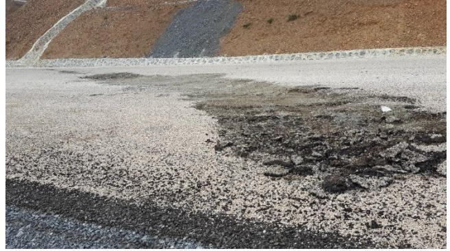
Şekil 2. Heyelanın sebep olduğu yol tahribatı
