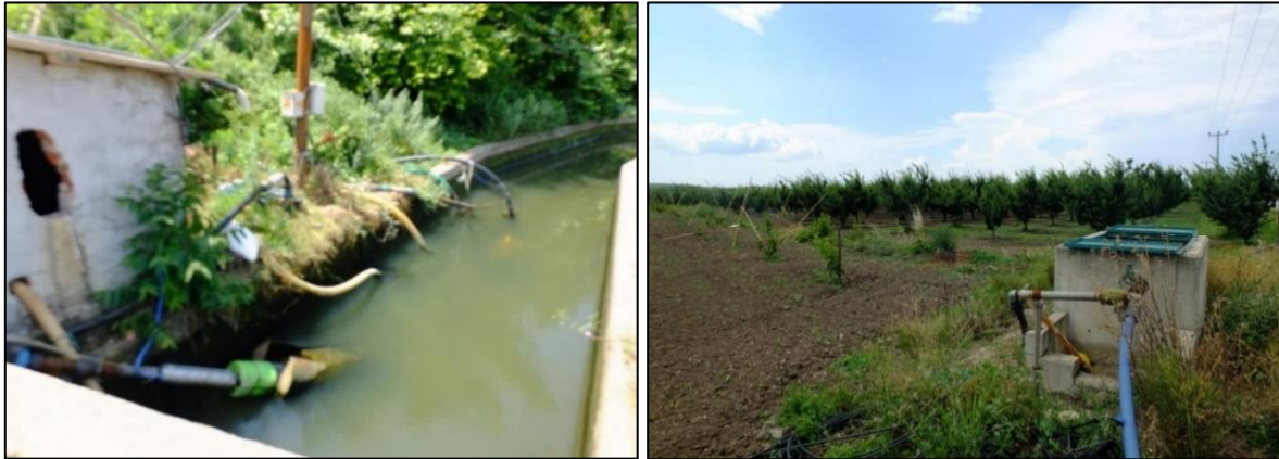
Foto 5. Umurbey Barajı sulama kanallarından faydalanma. Umurbey Ovası güney sulama kanalı (a), sulama kanalından küçük kanallarla taşınan sular (b)
