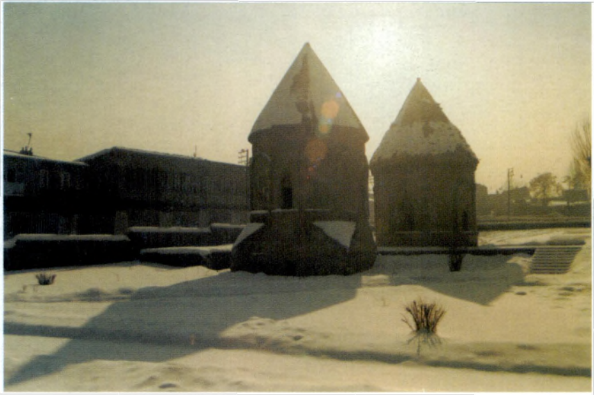
Resim 5 - II. ve III. kümbetlerin batıdan görünüşü
