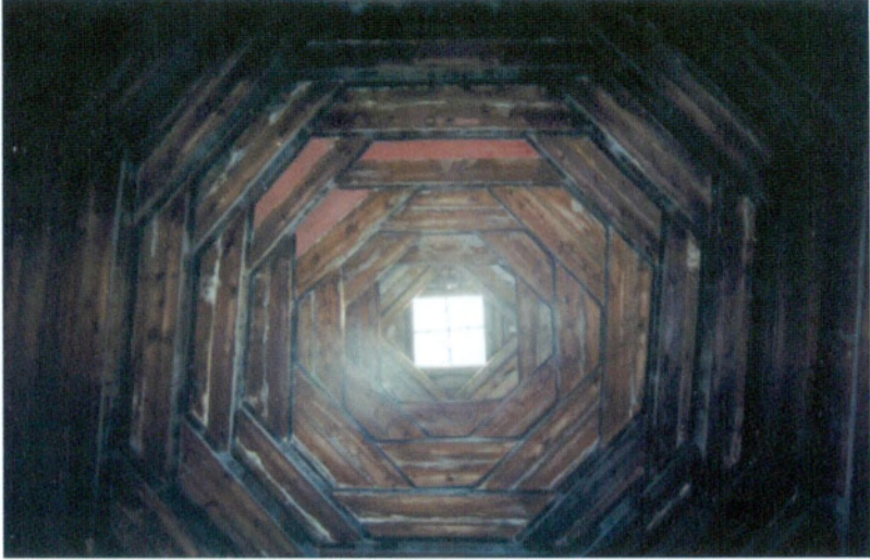
Resim 41 - Tandirevini örten kırkangıç tavan örneęi, Hanaęasıgil'in evi
