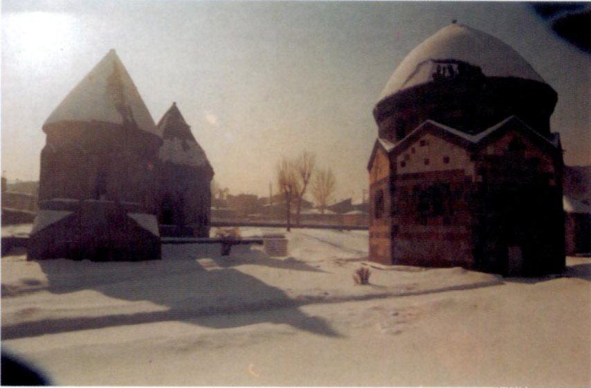
Resim 2 - Üç Kümbetlerin kuzeyden görünüşü
