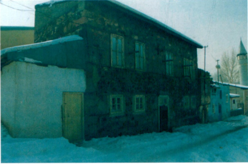
Resim 35 - 11 No'lu örneğe ait ön görünüş (Ketecioğlu evi)
