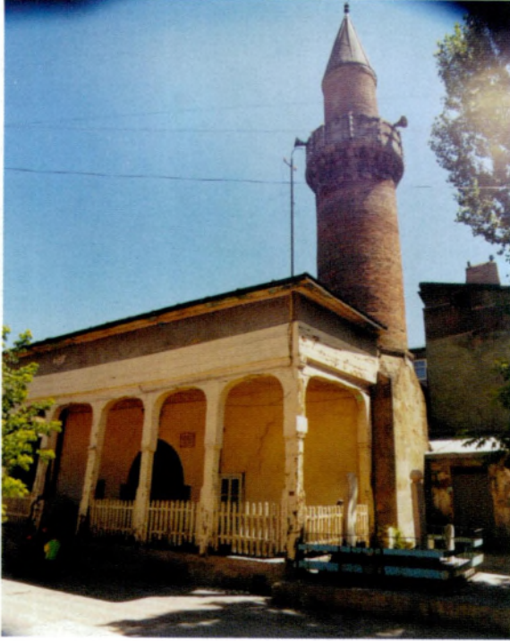
Resim 10. Camiinin avlusundan bir görünüş
