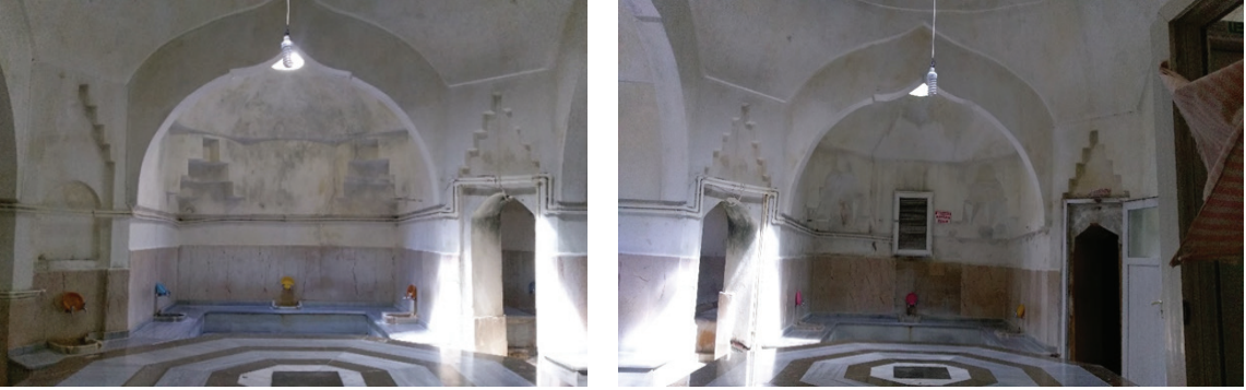
Fotoğraf 13 – 14. Amasya Kumacık Hamamı sıcaklık bölümü güneydoğu eyvan ve güneybatı eyvanı görünüşleri
