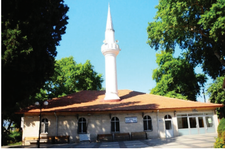
Resim 6: Hereke Fabrika-i Hümâyûn Camii Doğu Cephesi (Günümüz Durumu)
