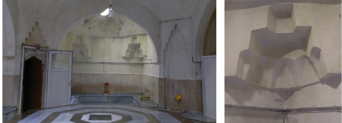
Fotoğraf 15 – 16. Amasya Kumacık Hamamı sıcaklık bölümü kuzeydoğu eyvanı ve kubbeye geçiş trompu
