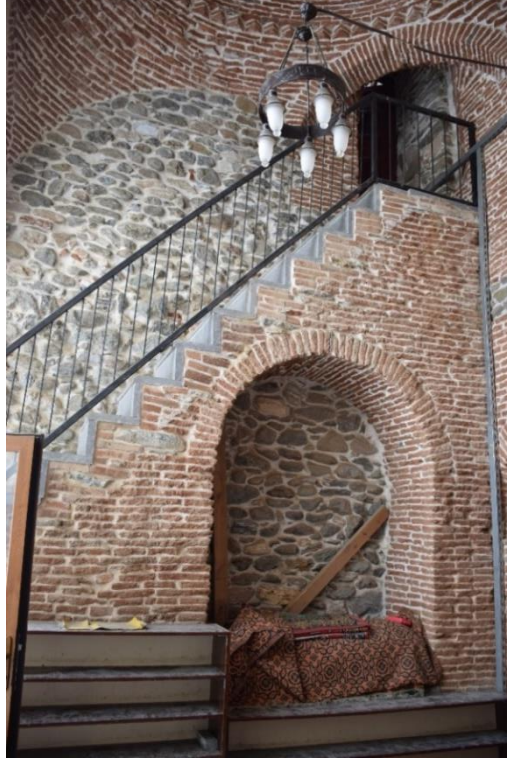
Resim 8. Muş Ulu Camii Minare gidiş merdiveni
