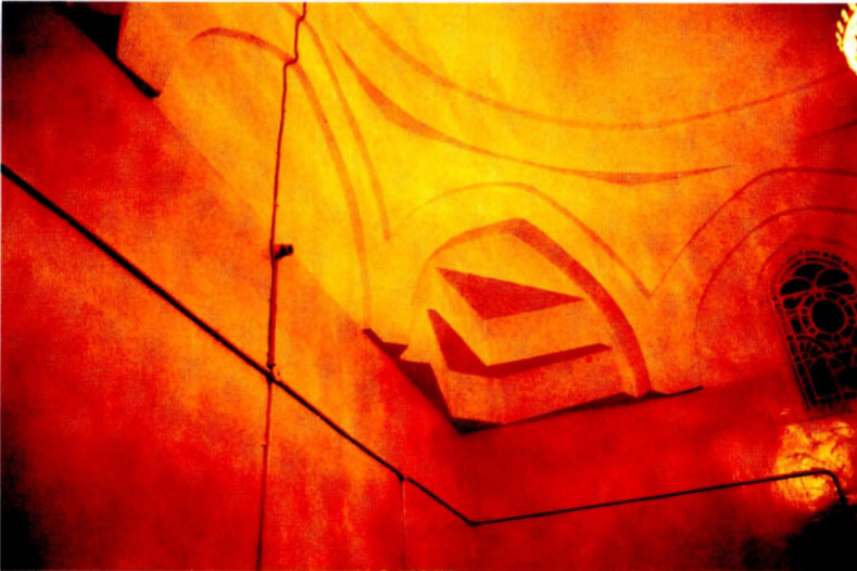
Resim 15 - Türbede kullanılan tromp geçiş elemanı
