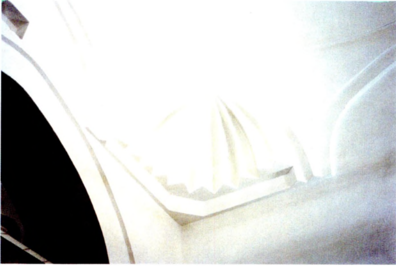
Resim 14 - Camide, kubbeye geçişte kullanılan istiridye kabuğu biçimli tromp
