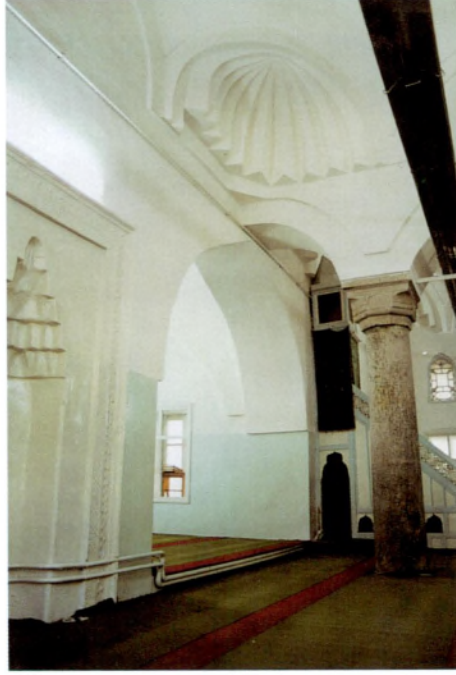
Resim 12 - Orta aks üzerinde askı kemerinin oturduğu sütun ve onu, güneyde eklenen küçük birimin bu mekana açıldığı tudor kemerinin kilit taşına bağlayan ilginç yarım kemer uygulaması
