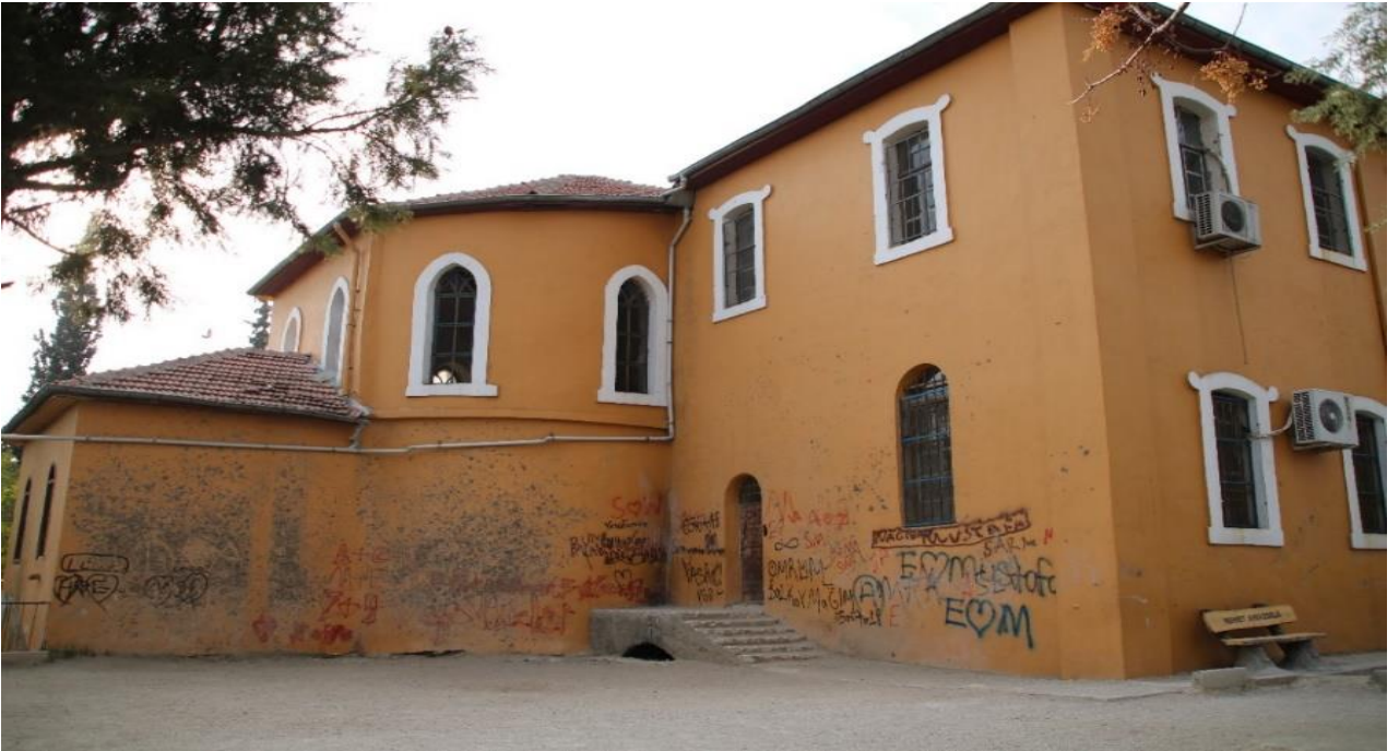
Resim 9. Yapının Apsis Cephesi
