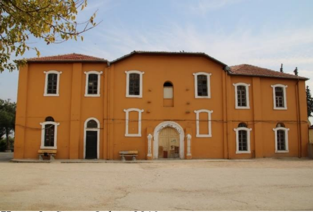
Resim 7. Yapının Kuzeybatı Cephesi
