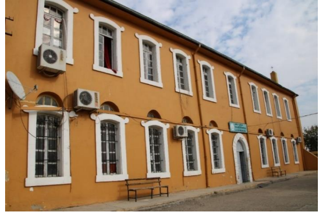
Resim 8. Yapının Güneybatı Cephesi
