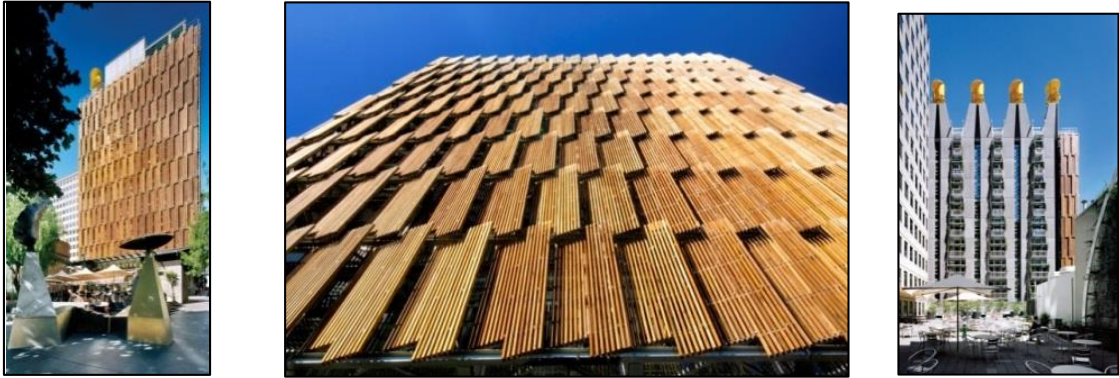
Şekil 9. Farklı açılardan CH2 binası [27]
