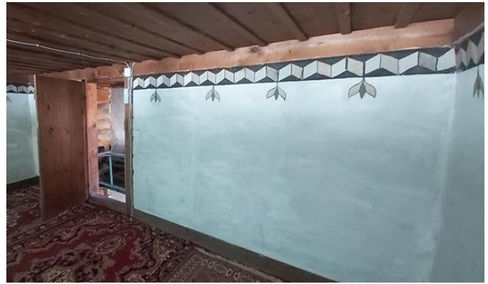
Resim 35. Kuzey Duvarı kadınlar Mahfeli
