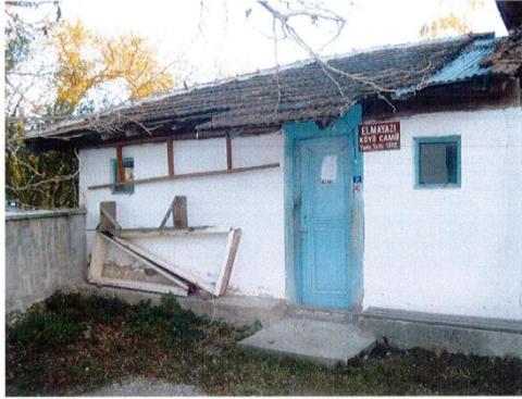
Resim 18. 2013-14 Restorasyonu öncesi Camii kuzey cephesi
