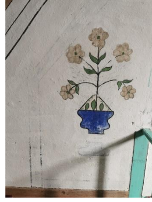
Resim 25. Doğu Duvarı Badana İle Kapatılmış Kalem İşleri
