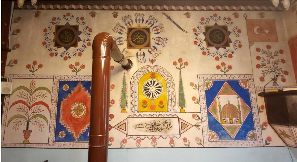
Resim 12. Doğu duvarı kalem işleri.
