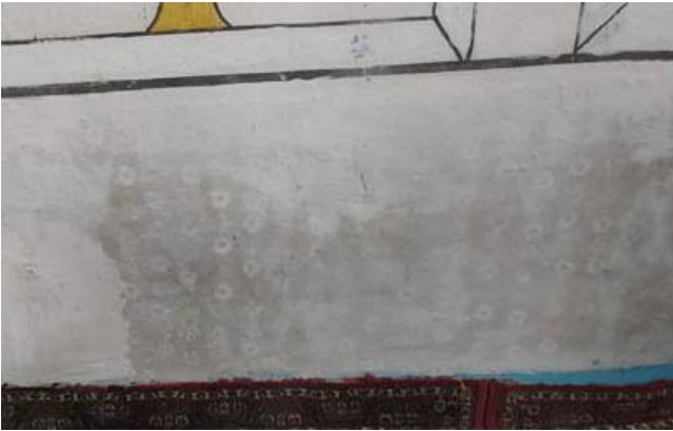
Resim 28. Doğu Duvarı Üzeri Badana İle Kapatılmış kalem İşi İzleri
