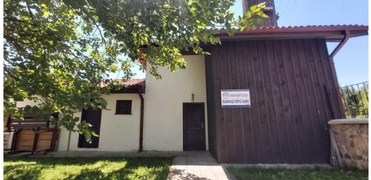
Resim 19. 2013-14 Restorasyonu sonrası Camii kuzey cephesi
