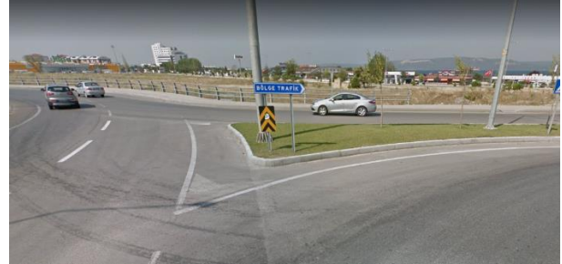
Şekil 2. Kuzeybatı yönündeki ayırıcı ada (Google Earth, 2020)
