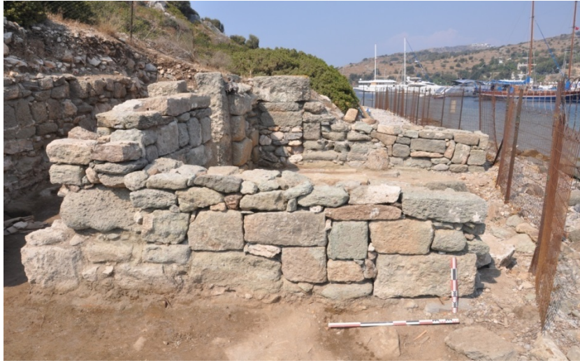
Resim 6 - Restorasyonundan Sonra Ön Oda Duvarları (İhtiyar, 2016: 89, Levha 8/B)
