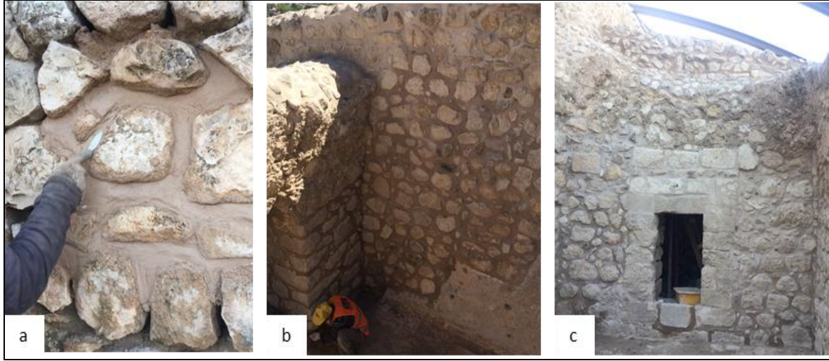
Şek. 17: Yamaç Külliye Kalıntılarının Duvar Örgülerinde Geçekleştirilen Derz Onarımları Çalışmalarına Örnek (a, b, c).
