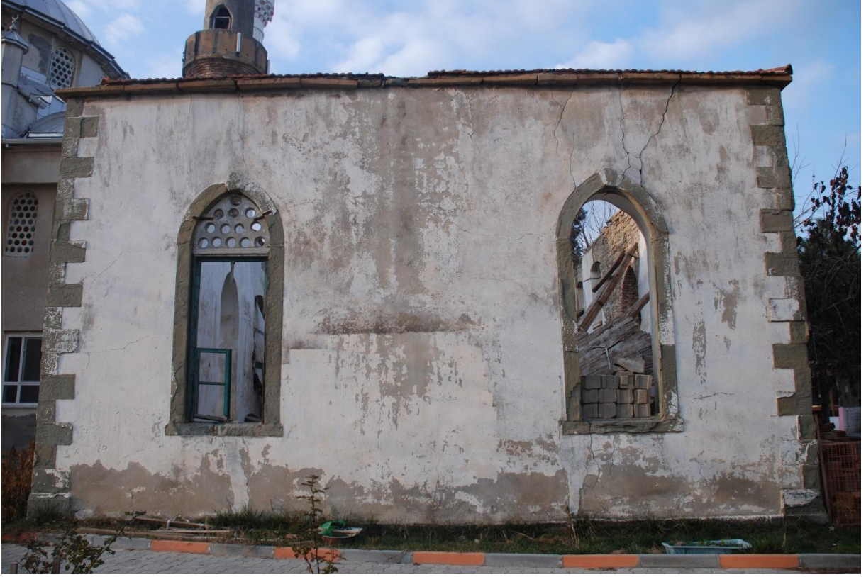
Res. 4: Koyunyeri Köyü Camii, Güney Cephesi
