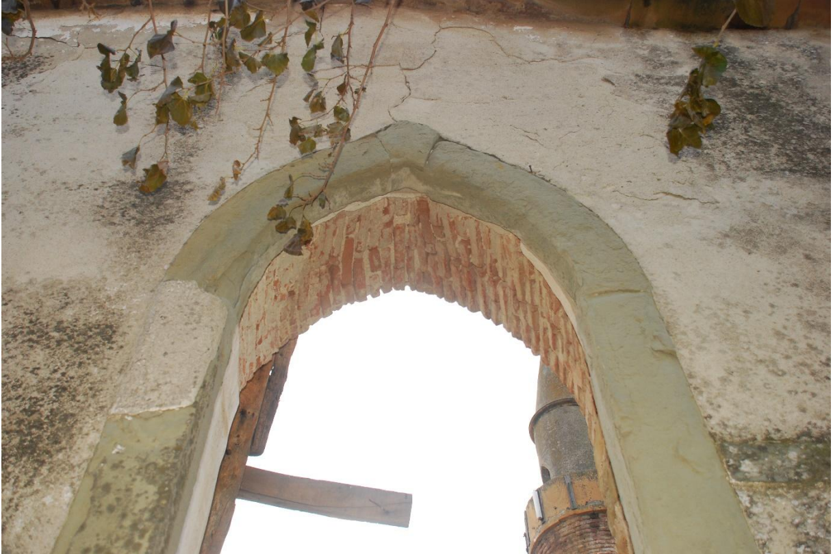
Res. 3: Pencerelelerin Kemer Karnında Tuğla Kullanımı
