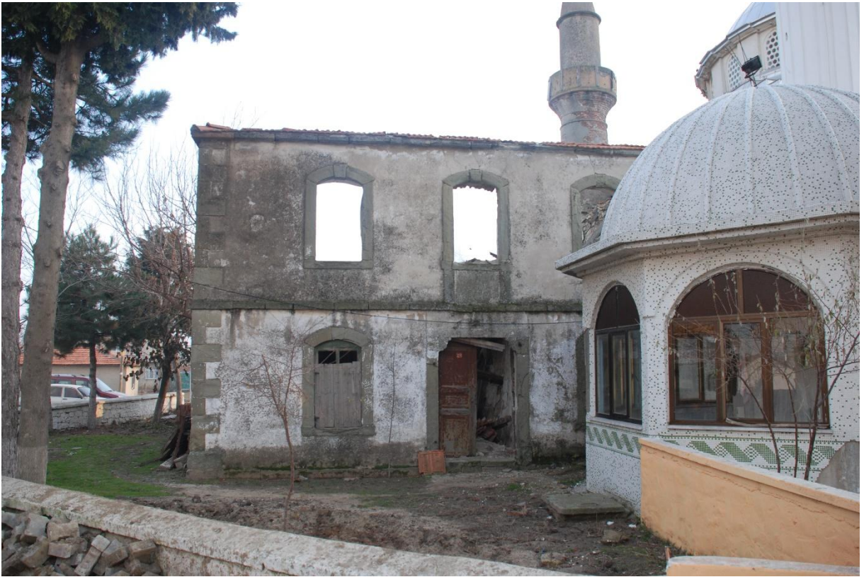
Res. 7: Koyunyeri Köyü Camii, Kuzey Cephe
