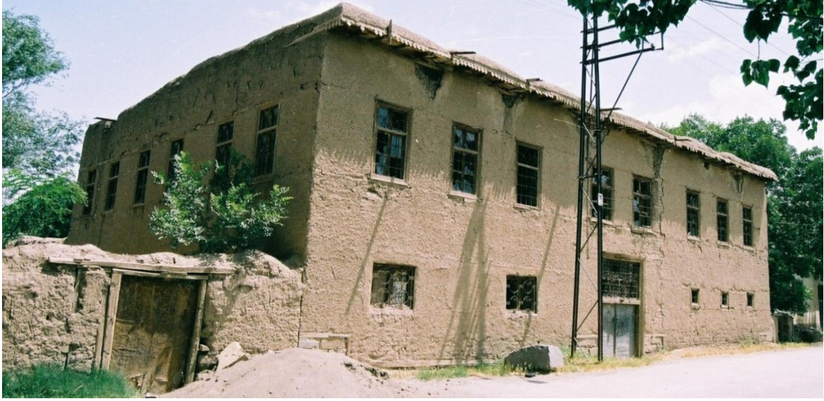
Şek. 31: Polat Yörükoğlu Evi Güneybatı Görünüşü (Ş. Öztürk-1997)
