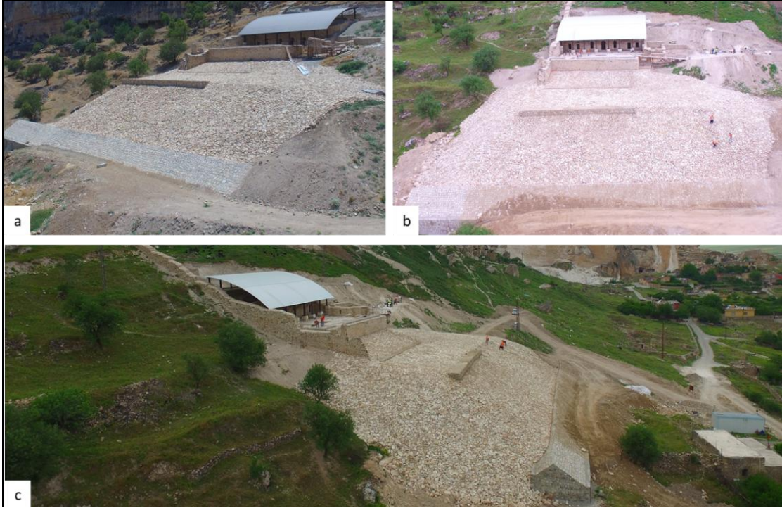
Şek. 27: Hasanköy Yamaç Külliyesi Kalıntılarının Su Altında Korunma Uygulamaları Sonrası Görünümü (a, b, c).
