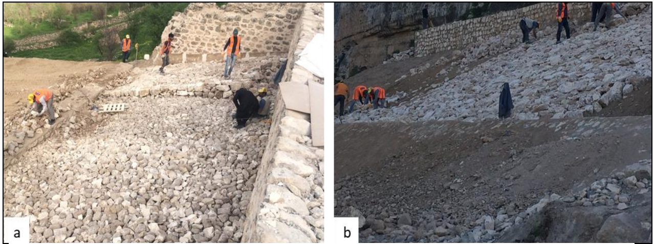
Şek 26: Külliye Kuzey (Medrese) Bölümü Kalıntılarının Su Altında Korunmasına Yönelik Son Uygulama Anroşman Katmanı Oluşturulma Çalışmaları (a, b).
