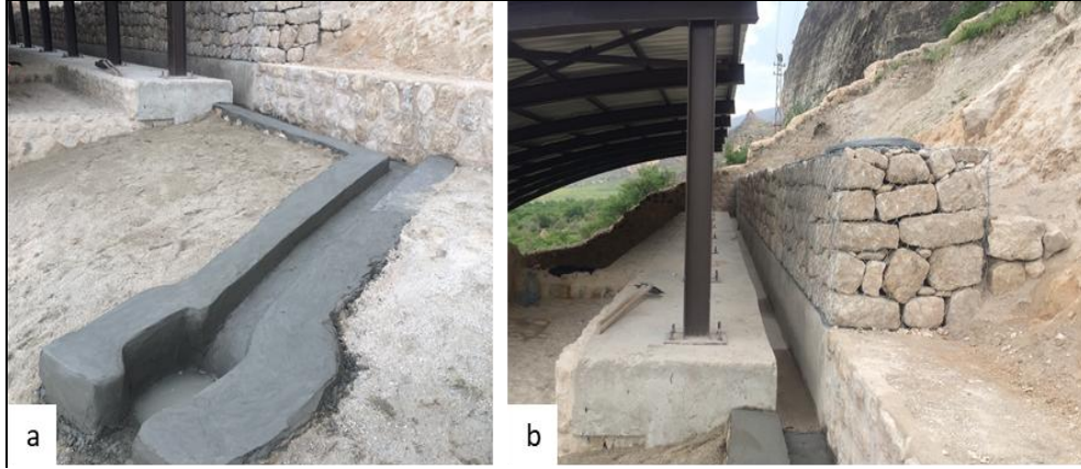
Şek. 29: Yamaç Külliyesi Cami Bölümünün Güney (Harim) Duvarı Arkasında Su Drenaj Hattı Yapılması Çalışmaları (a, b).
