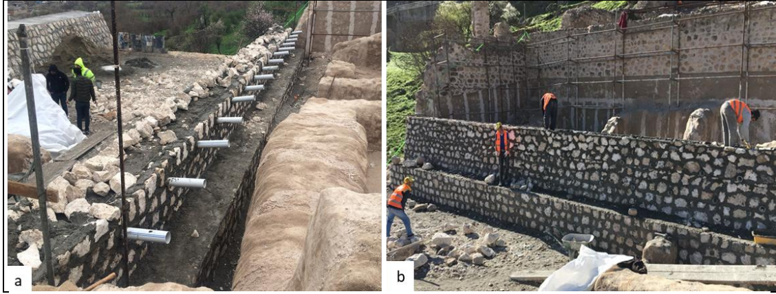
Şek. 23: Külliye Kuzey (Medrese) Bölümü Kalıntılarının Suyun Hareketine Karşı 3. Set Duvarının Yapım Çalışmaları (a, b).
