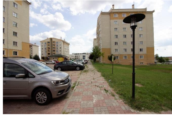
Şekil 6. Proje alanındaki kilitli parke ve beton parke döşemeler (Çay,R.D. arşivi)
