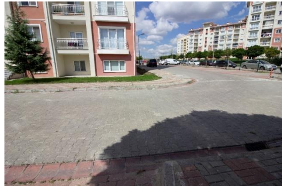
Şekil 9. Proje alanındaki beton drenaj oluğu ve drenaj ızgarası (Çay,R.D. arşivi)
