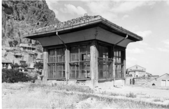
Resim3. Afyon Ulu Camii 1947 öncesi çatı üzerindeki aydınlık feneri (Odabaşı Mimarlık tarafından hazırlanan rapor)
