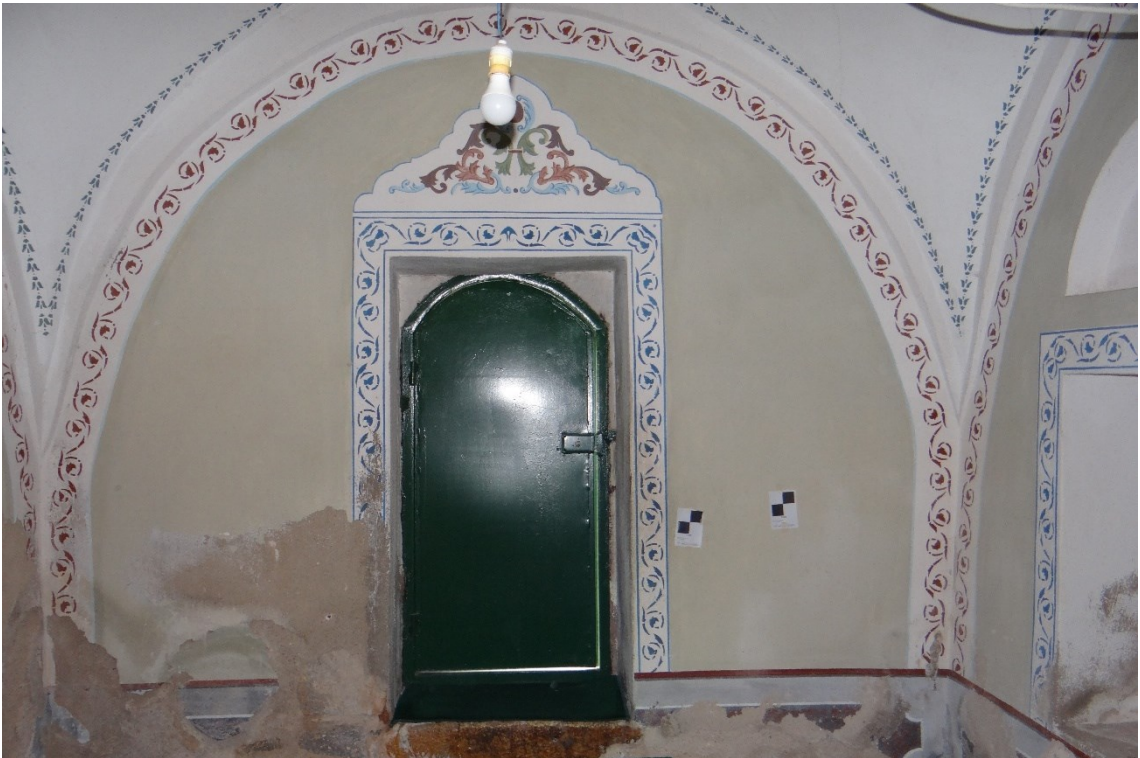
Fotoğraf 14. Ön bölüm kapısı içeriden görünüşü.
