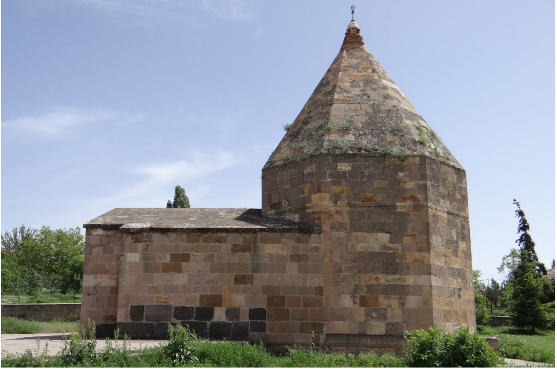
Fotoğraf 8. Kuzey cephe.
