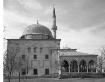
Figure 66. Kurşunlu Mosque Eastern Façade (Kayseri Vakıflar Genel Müdürlüğü Arşivi, 2019)
