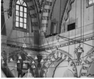
Figure 61. Kurşunlu Mosque Interior (Kayseri Vakıflar Genel Müdürlüğü Arşivi, 2019)
