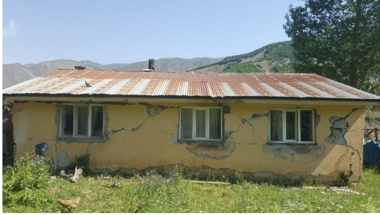
Şekil 8. Kayma davranışa bağlı hasar
