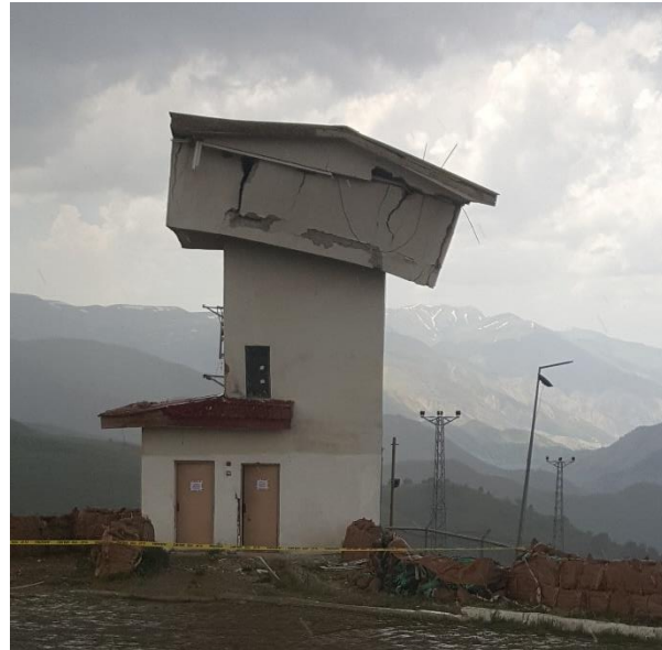
Şekil 11. Betonarme gözetleme kulesinde meydana gelen hasar
