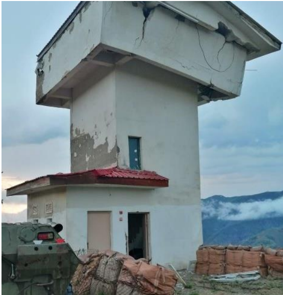
Şekil 11. Betonarme gözetleme kulesinde meydana gelen hasar
