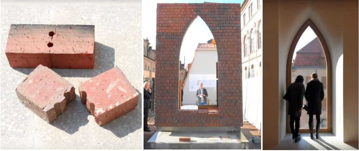
Şekil 20. (solda) Ortadan kırılan tuğlaların kırık tarafı cepheye bakmaktadır (Herzog, 2016) Şekil 21. (ortada) Cephe ve pencerenin 1:1 maketi (Herzog, 2016) Şekil 22. (sağda) Dıştaki gotik kemer ve içteki dikdörtgen çerçevenin arasında yorumlanan amorf yüzey (Herzog, 2016)
