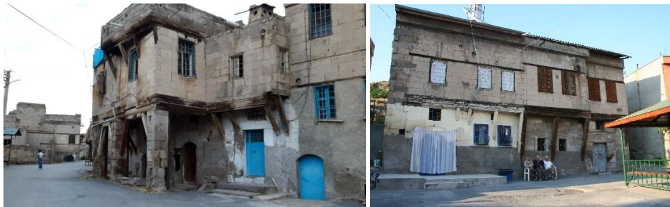
Şekil 14. (solda) 11297 ada 1-2-3-4-5 parseldeki yapı, (sağda) 11297 ada 12 parseldeki yapı (Sümeyye Kara, 2016)
