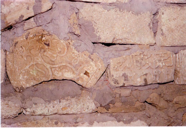
Resim 3 - Azerbaycan / Mereze, Diri Baba Türbesi. Kitabe parçalarının restorasyonda duvara yerleştirilmiş örnekleri (Fotoğraf Yaşar Çoruhlu, 1997).
