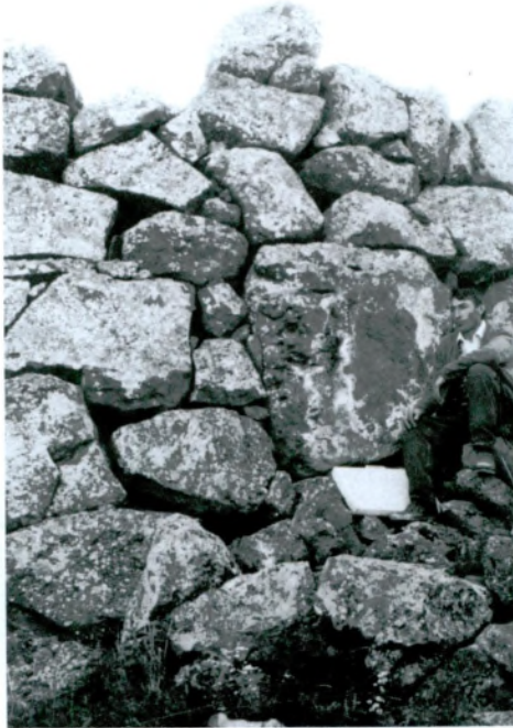
Resim 9: Karakale tahkimat duvarlarından ayrıntı.
