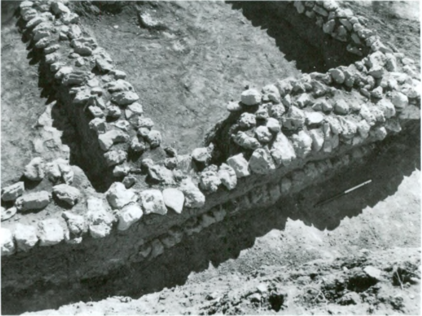
Levha 17/2 - İTÇ 5-4 yapı katları temelleri
