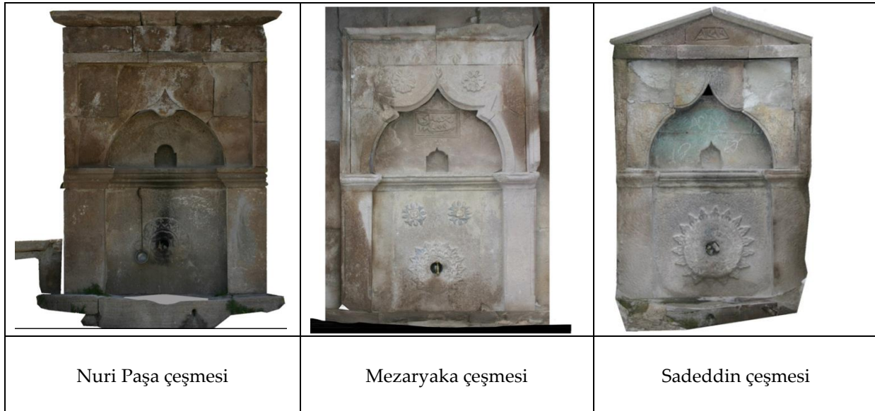
Şekil 8. Dijital tekniklerle oluşturulmuş ve Photomodeler yazılımı ile elde edilmiş 3 adet tarihi sille çeşmesi.
