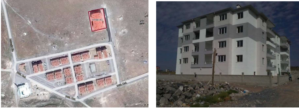
Şekil 1. Yapının arazi görünümü ve fotoğrafı
