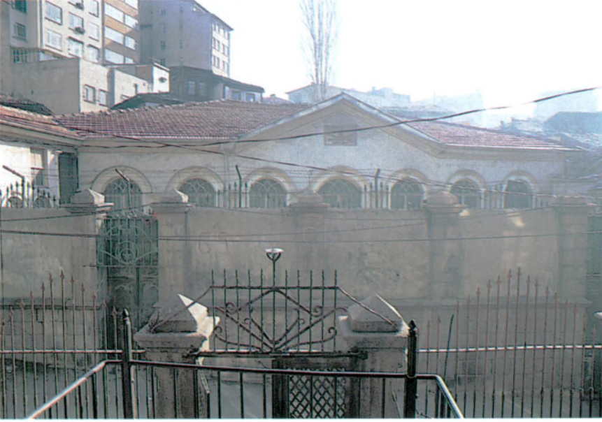
Res 14 – Sinagog - Genel görünüm. Synagogue - General view.
