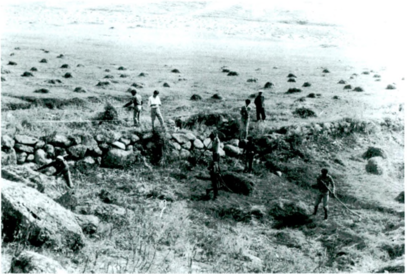
Resim 38 – Yukarı Argıt Baraj duvarının kuzeyden görünümü.
