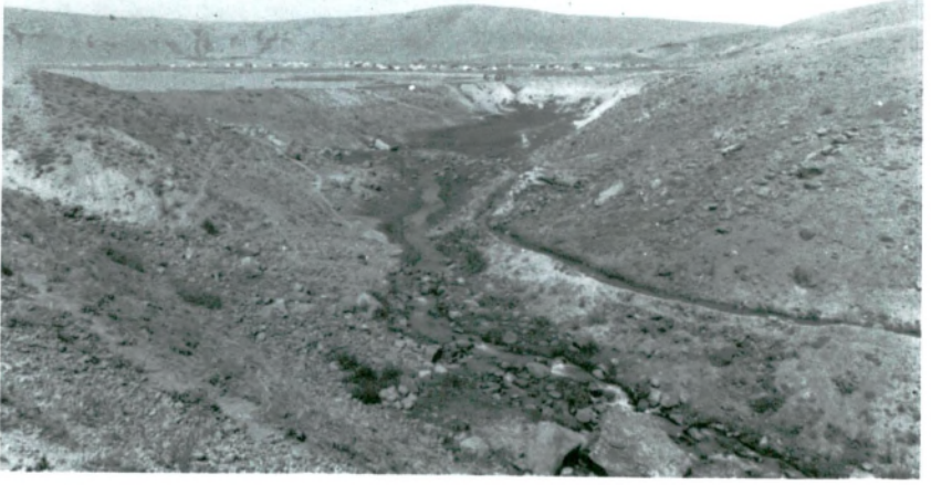
Resim 25 – Meydan Gölü ve güney ucuna Van Toprak Su Bölge Müdürlüğü tarafından yaptırılan yeni baraj duvarı.
