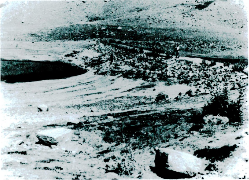
Resim 2 - Süphan Gölü'nün güney ucuna inşa edilen Yukarı Süphan Barajı.
