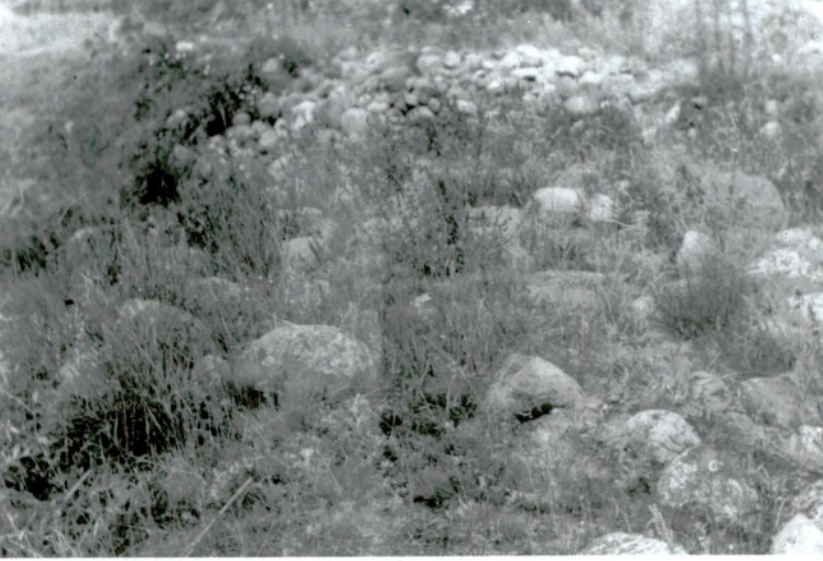
Resim 51 – İri taşlarla yapılan Sünnet Nebi Baraj duvarı.
