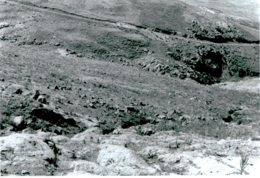
Resim 55 – Harabe mevkiinde halk tarafından tahrip edilen Urartu konut kalıntıları.
