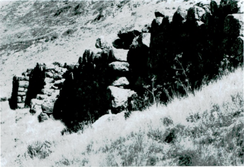
Resim 8 – Kurtin-bastiyon tekniğinde örülen Çavuştepe su biriktirme yapısının kuzey duvarı.
