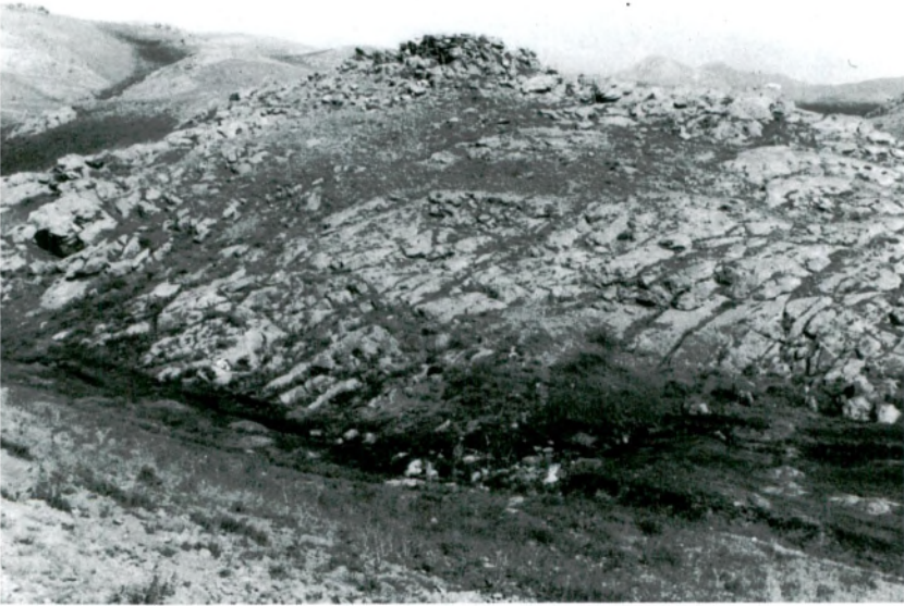
Resim 20 – Dar ve kayalık vadiye yapılan Arç Barajı ve bunu koruyan Dev Evi'nin güneybatıdan görünümü.
