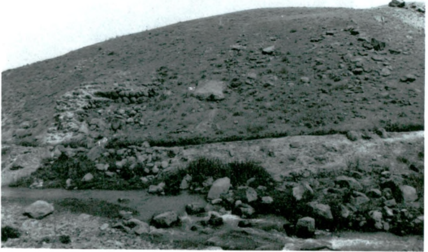
Resim 26 – Meydan Gölü suları tarafından parçalanmış baraj duvarları, budadan.
