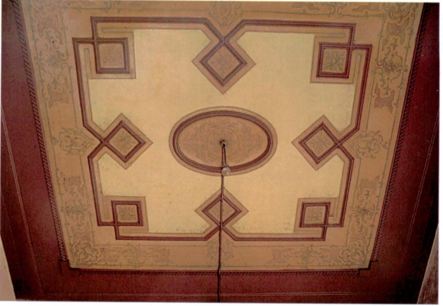
Res. 8 – Merdiven sahanlığının kalem işi bezemeli tavanı. "Kalem işi" ornamented ceiling from the staircase landing.
