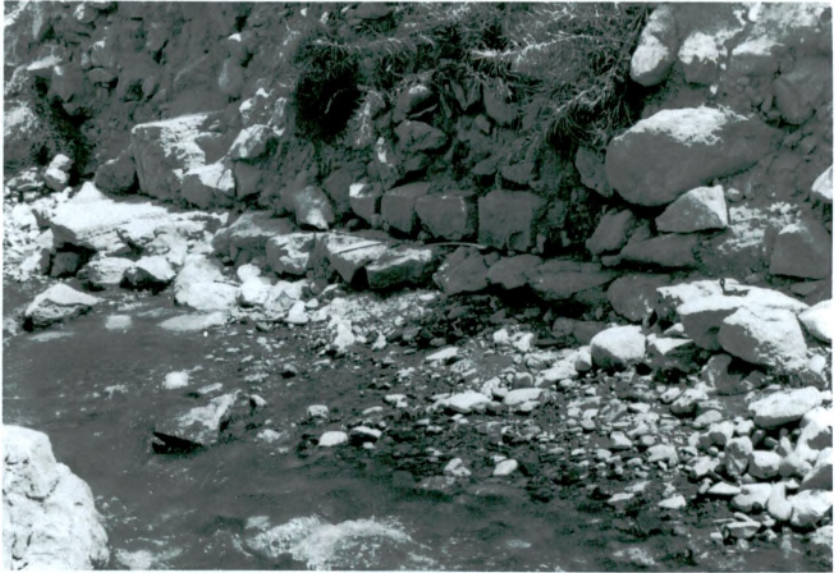
Resim 14: Baraj duvarının güneyinde su akıtma savağının geçtiği temel kısmı.
