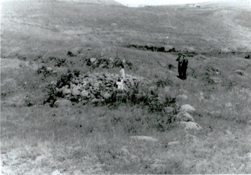
Resim 52 – Ortası baraj suları tarafından parçalanan Sünnet Nebi Baraj duvarı.
