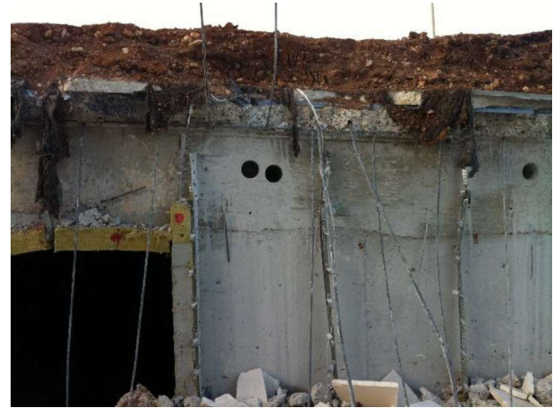
Şekil 8 Binanın göçen kısmından alınmış karot numuneler
