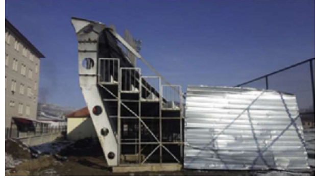
Şekil 3 Göçen konsol şeklindeki çelik tribün
