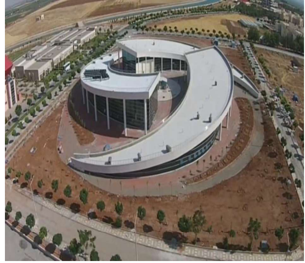
Şekil 2 GAP YENEV binasının kuş bakışı görünümü.
