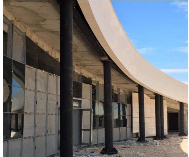
Şekil 18 Göçme oluşmayan çatı döşemelerinin çelik konstrüksiyon sistemle güçlendirilmiş hali
