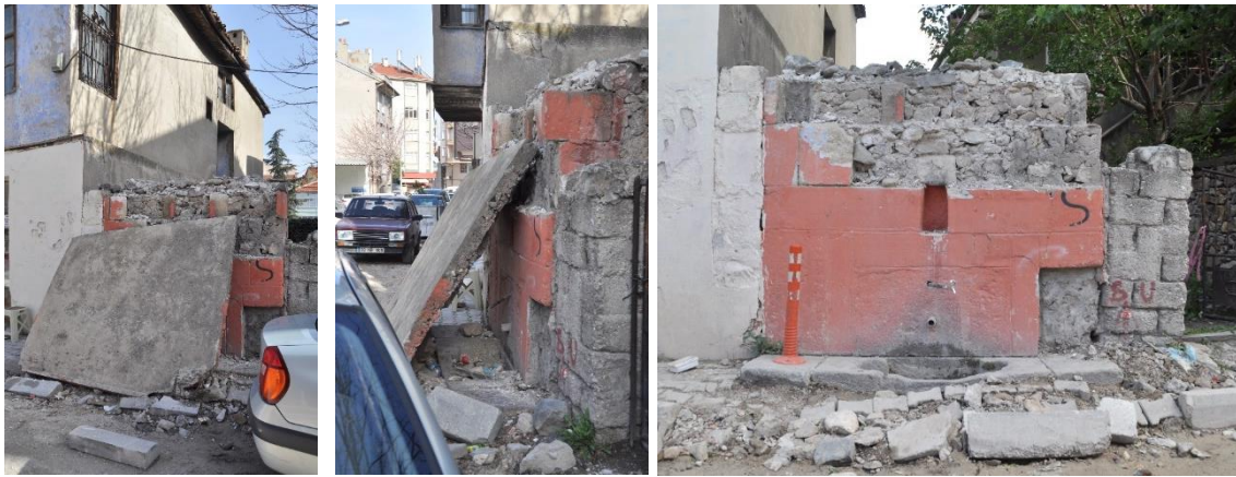
Şekil 8. Aldanzade Hacı Osman Çeşmesi kaza sonrası durumu
