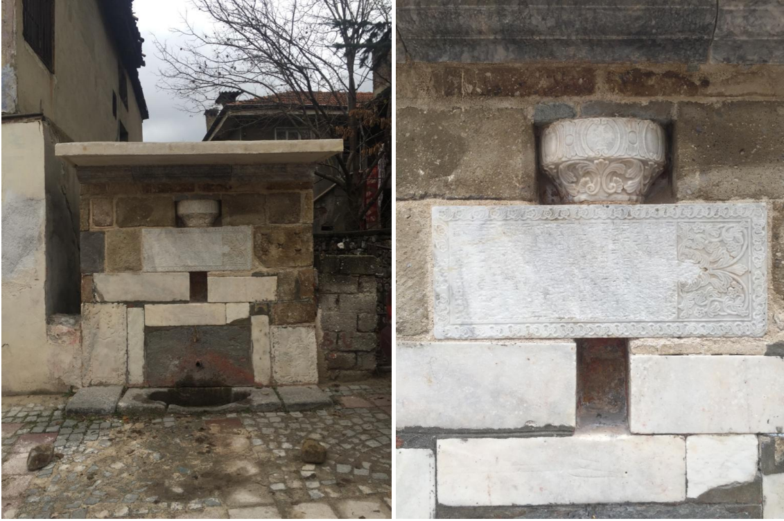
Şekil 16. Aldanzade Hacı Osman Çeşmesi restorasyon sonrası kuzeybatı cephesi ve devşirme sütun başlığı
