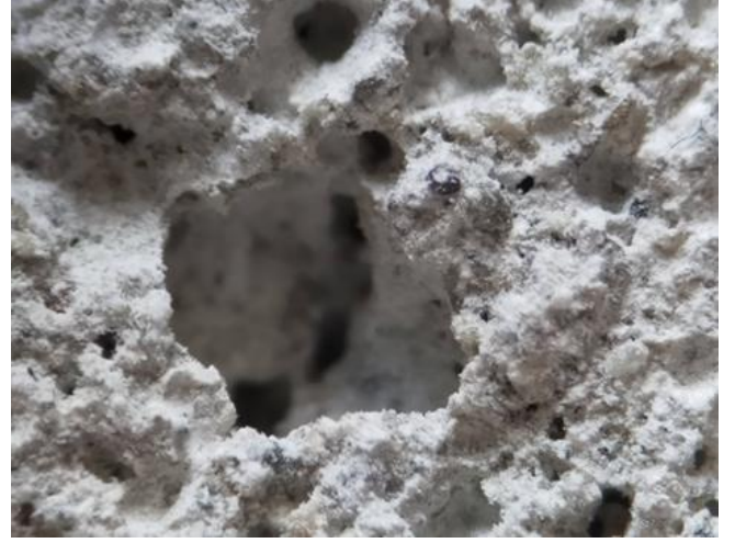
Şekil 7. MB2 örneğine ait genel yapısal görünümü.
