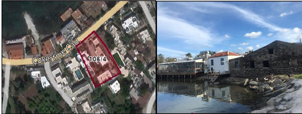
Şekil 3. Uygulama sahasındaki 1000 nolu parsel (yeni 106 ada- 4 parsel) ve komşuluğunda olup kıyı alanında (karayolunun deniz tarafında) kalan taşınmazların uydu haritası (a) (TKGM-Parsel Sorgu Sistemi) ile kıyı alanında kalan 998 nolu parsel üzerindeki yapı ve tesislerden bir görüntü (b) (2019) (Satellite map of parcel no 1000 (new block 106 - parcel 4) in the implementation area and the immovables in the neighboring area (on the sea side of the highway) (a) (TKGM-Parcel Inquiry System) and a view of the buildings and facilities on the parcel no. 998 in the coastal area (b) (2019) )
